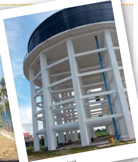
Batas Paip water tank
