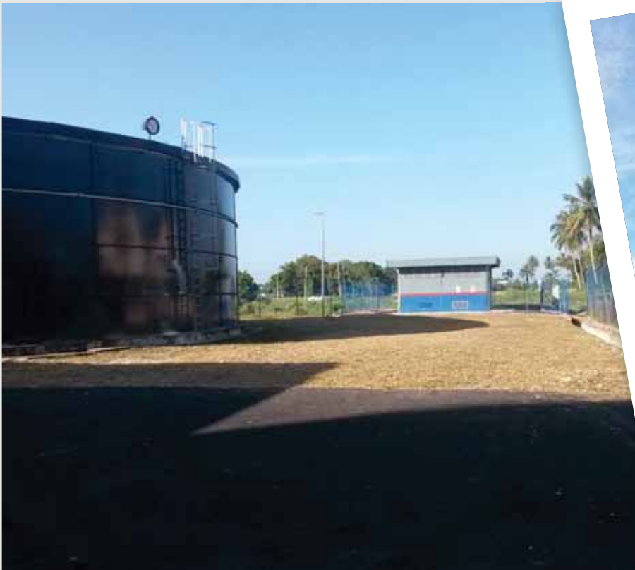
Batas Paip water tank
