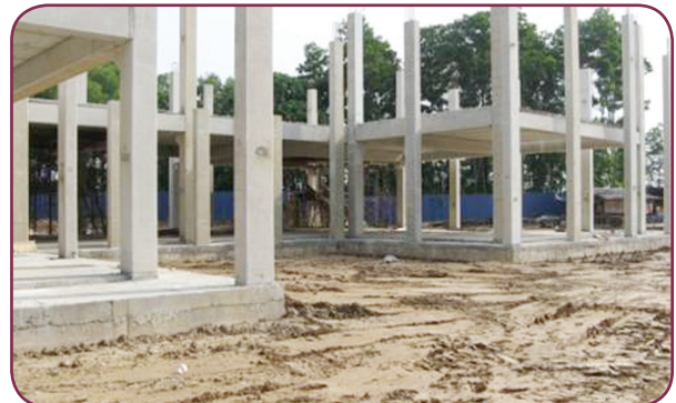
Projek Cawangan Audit Negeri Sembilan yang masih dalam pembinaan (Kerja-kerja menaikkan tiang dan slab konkrit aras satu)
