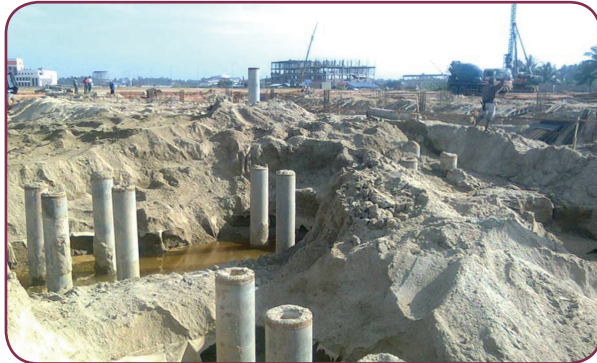
Projek Cawangan Audit Negeri Kelantan yang masih dalam pembinaan (Kerja-kerja penggalian cerucuk dan penyediaan pile cap )
