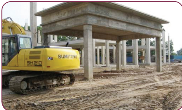
Projek Cawangan Audit Negeri Sembilan yang masih dalam pembinaan (Kerja-kerja menaikkan tiang dan slab konkrit aras satu)
