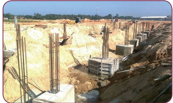
Projek Cawangan Audit Negeri Kelantan yang masih dalam pembinaan (Kerja-kerja penggalian cerucuk dan penyediaan pile cap )
