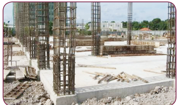
Projek Cawangan Audit Negeri Melaka yang masih dalam pembinaan (Kerja-kerja slab konkrit aras tanah)
