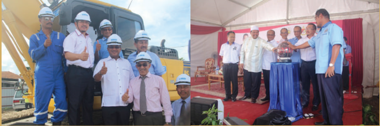
Majlis Pecah Tanah Wisma Audit telah disempurnakan oleh YB Yang Dipertua Dewan Undangan Negeri Terengganu mewakili YAB Menteri Besar Terengganu bertempat di Kawasan Pembangunan Bukit Besar/Padang Hiliran, Mukim Gelugor Raja, Kuala Terengganu pada 11 November 2015.
