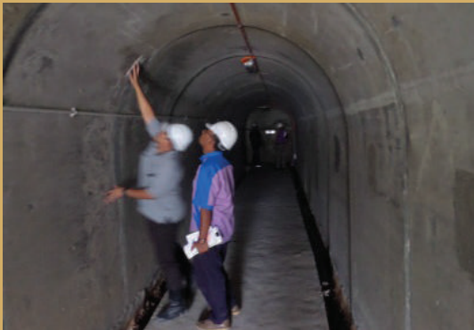
Lawatan dan pengesahan di tapak bagi projek pembinaan di Empangan Murum, Belaga Sarawak
