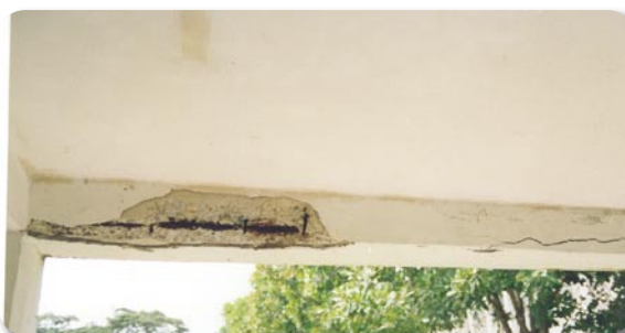
Konkrit Rasuk Bangunan Pecah dan Retak. Konkrit telah gugur, menampakkan besi konkrit berkarat dan berlaku keretakan.
