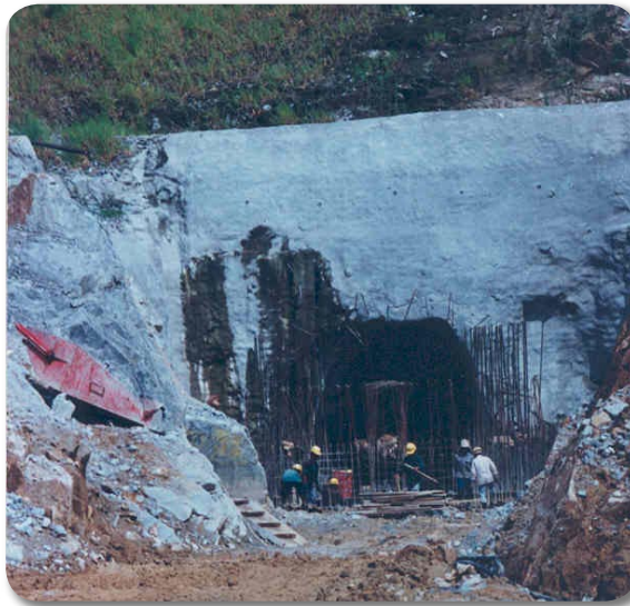
Projek Pembinaan Empangan Ulu Sg. Muar, Kuala Pilah Negeri Sembilan.
