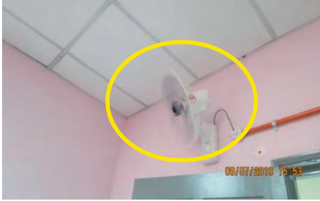
Asrama Kompleks Sukan Seremban 2 - Kipas Dinding Asrama yang Tidak Mempunyai Front Guard/Grill (09.07.2019) (Sumber: Jabatan Audit Negara)
