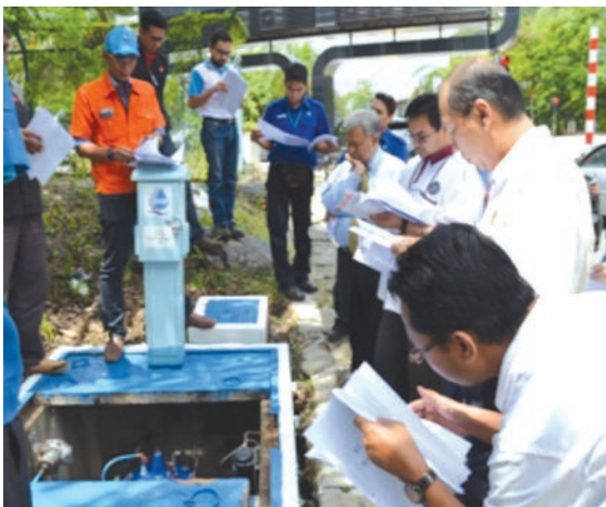
Lawatan dan semakan PRV di tapak bagi Kajian Non Revenue Water
