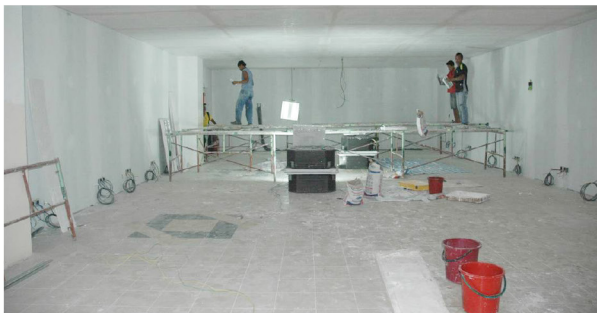
Kerja-kerja pengubahsuaian sedang dijalankan di AIMM untuk Pusat Pemeriksaan Dokumen JIM
