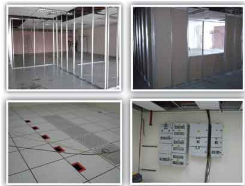
Kerja-kerja pembinaan pusat data di JANM Cawangan Johor
