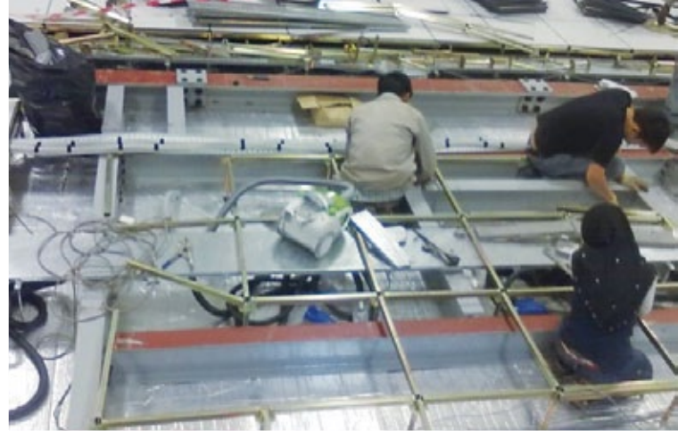
Kerja-kerja pemasangan Beam bagi memperkuat struktur lantai di Pusat Data
