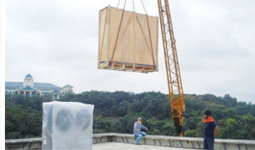
Kerja-kerja meletakkan Chiller Air-Cond di bumbung bangunan JANM
