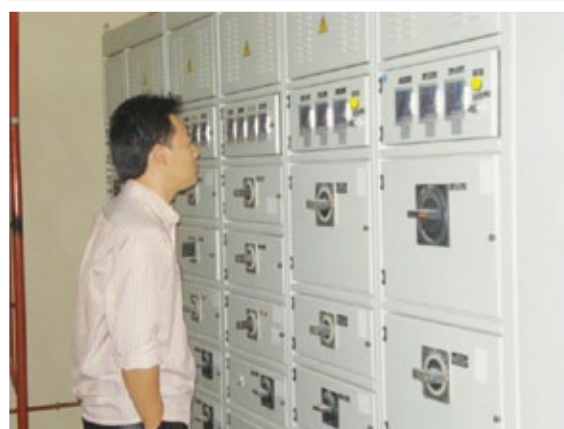
Kerja-kerja pengujian DB elektrik baru di pusat data JANM Melaka
