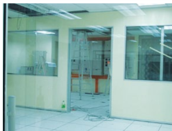
Kerja-kerja pembinaan pusat data di JANM Melaka
