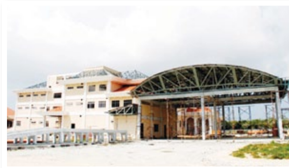
Pembinaan Garaj Bas
