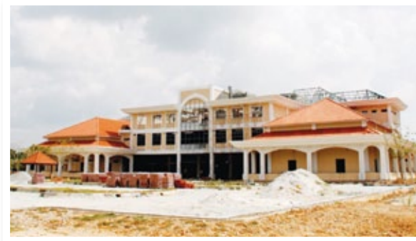
Pembinaan Bangunan Pentadbiran
