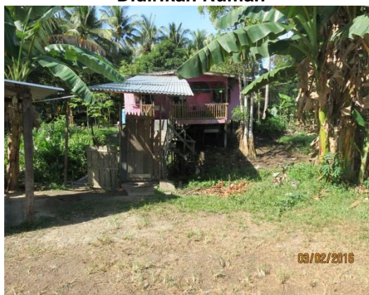
Gambar 3.9 Tapak Tanah Telah Dicerobohi Dan Didirikan Rumah
