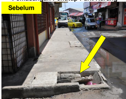
Gambar 2.11 Pemasangan Penutup Parit Kurang
