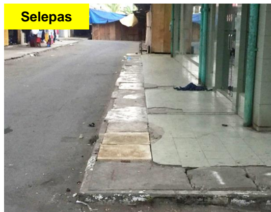
Gambar 2.14 Penutup Parit Telah Dipasang
