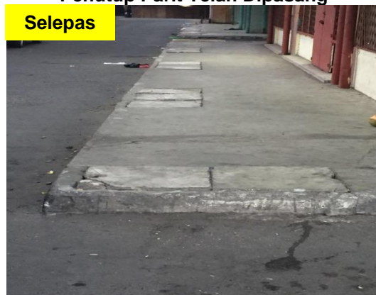
Gambar 2.12 Penutup Parit Telah Dipasang
