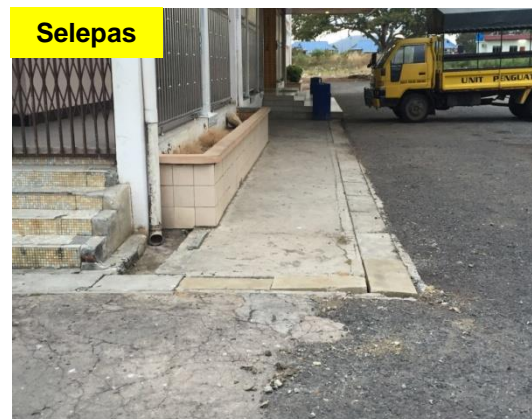
Gambar 2.16 Penutup Parit Telah Dipasang
