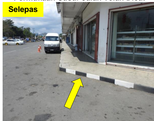
Gambar 2.8 Permukaan Susur Jalan Telah Dicat
