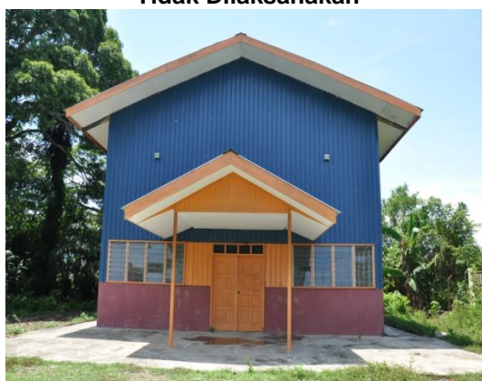
Gambar 2.17 Kerja Penyambungan Bekalan Elektrik Tidak Dilaksanakan
