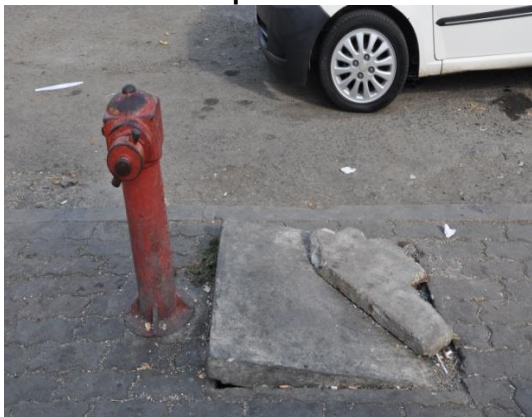
Gambar 2.24 Penutup Parit Pecah
