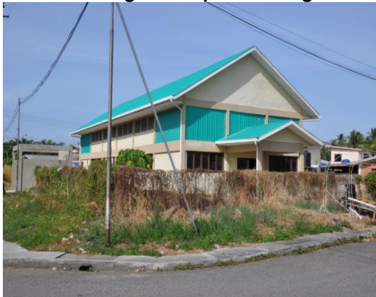
Gambar 2.19 Dewan Serbaguna Siap Belum Digunakan
