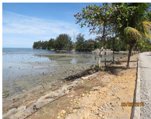
Gambar 3.7 Tapak Tanah Perlu Ditimbun Sebelum Pembangunan Dibuat
