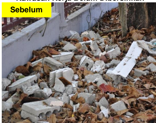
Gambar 2.9 Kawasan Kerja Belum Dibersihkan
