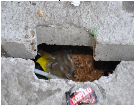
Gambar 2.26 Penutup Parit Pecah
