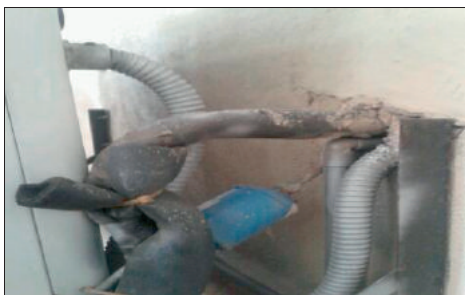
Aras Bumbung - Paip Konduit 'Mudah Lentur' Pada Condenser Unit Berkarat (21.01.2013)
