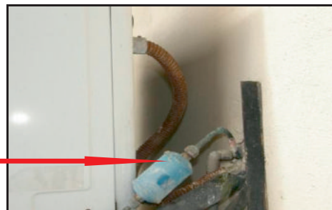
Aras Bumbung - Paip Konduit 'Mudah Lentur' Pada Condenser Unit Berkarat (21.01.2013)
