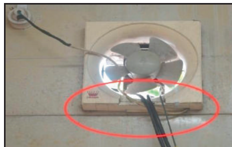
Kem Pulau Sibuan, Sabah - Pemasangan Kabel Yang Tidak Sempurna (20.12.2012)
