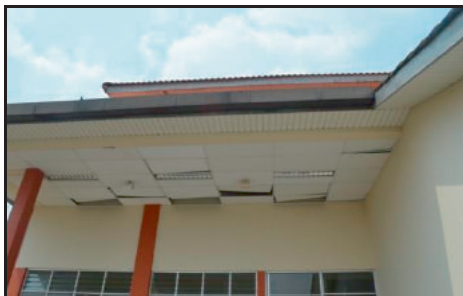
Surau (Fasa 2) - Siling Terangkat Di Anjung Surau (27.03.2013)
