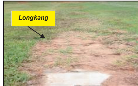
Padang SMK Dato' Undang Musa Al-Haj, Negeri Sembilan - Longkang Saliran Air Telah Ditutupi Tanah Dan Lumpur (10.12.2012)
