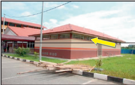
Tandas SMK Kuala Perlis, Perlis - Bahagian Atas Antara Beam Dan Siling Bangunan Tandas Sekolah Yang Telah Dipasang Jeriji (28.11.2012)
