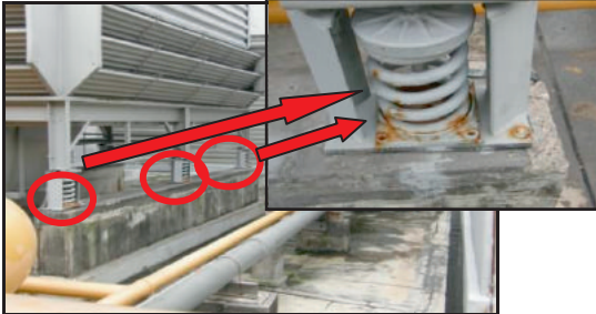
Aras Bumbung - Skru Dan Peredam Pada Tapak (Base Support) Berkarat (16.01.2013)
