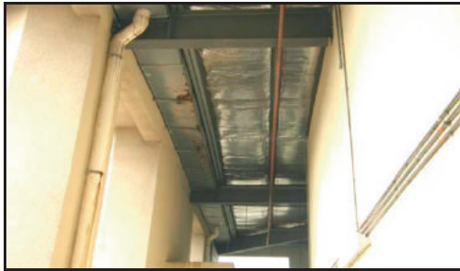
Aras Bumbung - Gutter Jenis 'Galvanised Iron' Berkarat (21.01.2013)
