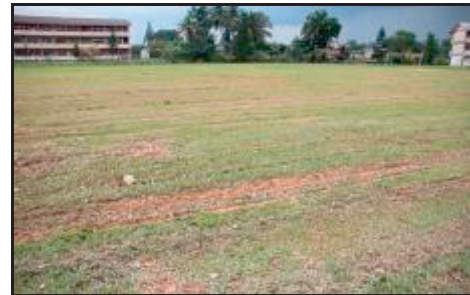
Padang SMK Seri Ampangan, Negeri Sembilan - Keadaan Padang Yang Tidak Rata (10.12.2012)
