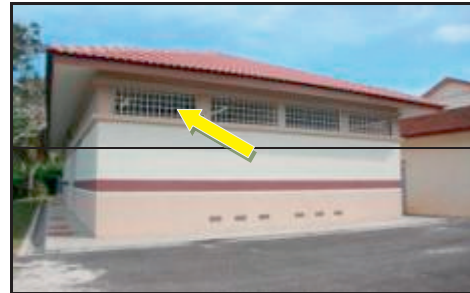
Tandas SMK Tengku Sulaiman, Perlis - Bahagian Atas Antara Beam Dan Siling Bangunan Tandas Sekolah Yang Telah Dipasang Jeriji (29.11.2012)
