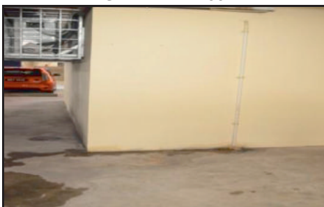
Basement 2 - Pengaliran Air Dari Compressor Penghawa Dingin (21.01.2013)
