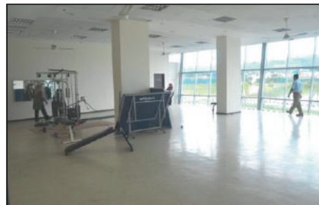
Bangunan Markas SMART (Fasa 2) - Bilik Persediaan Lelaki Di Aras 2 Yang Tidak Mempunyai Pengudaraan Menyebabkan Ianya Panas Dan Berbau (27.03.2013)
