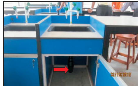
SK Pantu, Sri Aman - Singki Dalam Bilik Makmal Tidak Dilengkapkan Dengan Paip Air Dan Saluran Air Keluar (02.10.2012)
