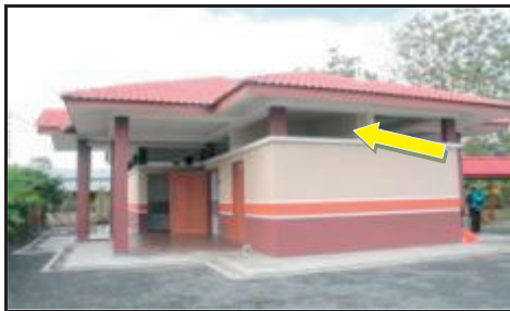
Tandas SK Kampong Serdang, Perlis - Reka Bentuk Bangunan Tandas Mempunyai Ruang Terbuka Antara Beam Dan Siling (27.11.2012)
