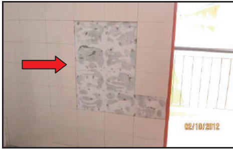
SK Pantu, Sri Aman - Jubin Dinding Tertanggal Di Tandas Murid Lelaki (02.10.2012)
