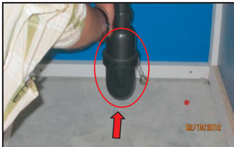
SK Pantu, Sri Aman - Singki Dalam Bilik Makmal Tidak Dilengkapkan Dengan Paip Air Dan Saluran Air Keluar (02.10.2012)
