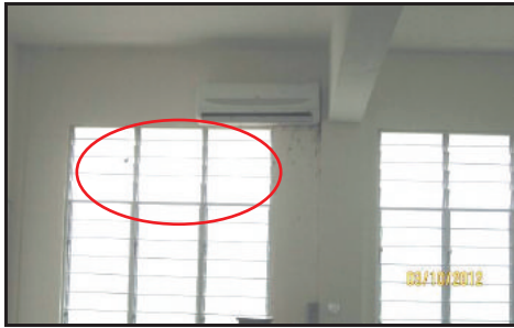
SK Lela Pahlawan, Sri Aman - Daun Tingkap Di Bilik Perpustakaan Sekolah Tidak Dapat Ditutup Rapat (03.10.2012)
