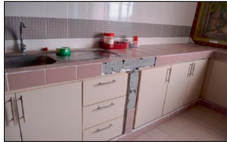
Bangunan Markas SMART (Fasa 2) - Jubin Di Bilik Pantri Tercabut (27.03.2013)
