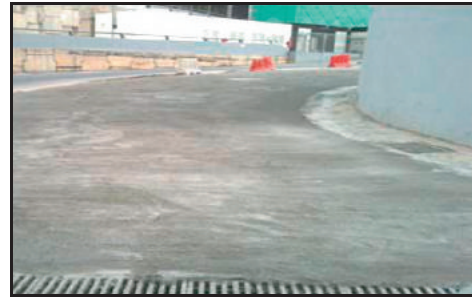
Laluan Lori (Outbound) - Tindakan Telah Diambil (Sumber : BPH - 26.08.2013)
