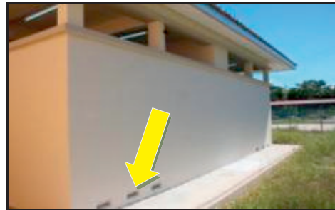
Tandas SMK Labuan, W.P. Labuan - Ruang Udara Bangunan Tandas Yang Kecil Dan Sesuai (19.12.2012)
