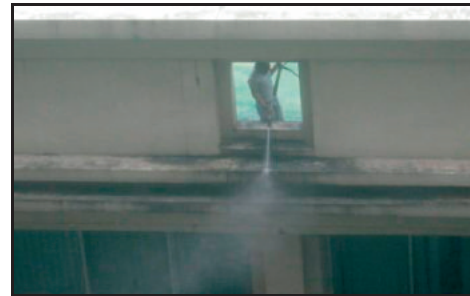
Aras Bumbung - Tindakan Telah Diambil (Sumber : BPH - 02.09.2013)
