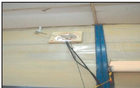
Kem Pulau Sibuan, Sabah - Pemasangan Kabel Yang Tidak Sempurna (20.12.2012)
