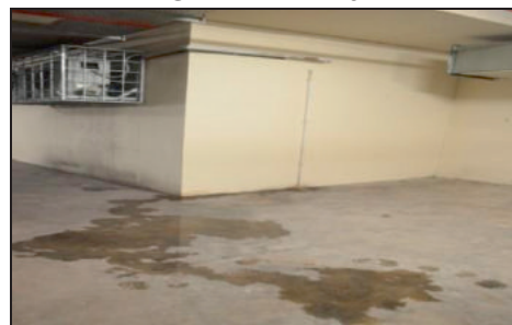
Basement 2 - Pengaliran Air Dari Compressor Penghawa Dingin (21.01.2013)
