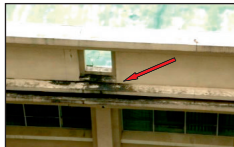
Aras Bumbung - Kemas Pada Tiang Dan Gutter Berlumut (21.01.2013)
