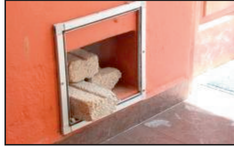
Tandas SK Sena, Perlis - Lubang Udara Ditutup Dengan Batu Bata Bagi Menghalang Haiwan Dan Serangga Masuk (30.11.2012)
