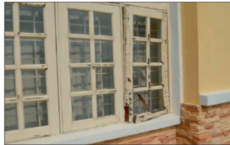
Kwarters SMART, Banglo Permata (Fasa 1) - Gutter Yang Tidak Dipasang Bagi Mengelakkan Aliran Hujan Dari Bumbung Terus Ke Tingkap Menyebabkan Daun Tingkap Kayu Reput (25.03.2013)
