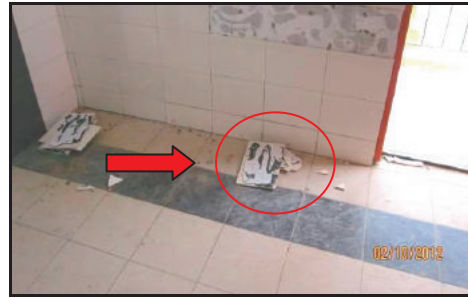
SK Pantu, Sri Aman - Jubin Dinding Tertanggal Di Tandas Murid Lelaki (02.10.2012)
