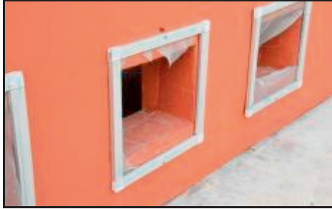
Tandas SK Sena, Perlis - Jaring Lubang Udara Telah Koyak Dan Rosak (30.11.2012)
