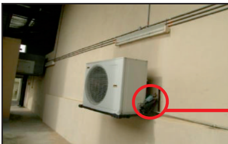
Aras Bumbung - Paip Konduit 'Mudah Lentur' Pada Condenser Unit Berkarat (21.01.2013)
