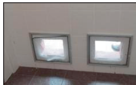
Tandas SMK Raja Puan Muda Tengku Fauziah, Perlis - Jaring Lubang Udara Didapati Telah Koyak Dan Rosak (27.11.2012)
