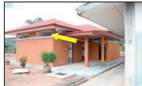
Tandas SMK Undang Jelebu, Negeri Sembilan - Reka Bentuk Bangunan Tandas Mempunyai Ruang Terbuka Antara Beam Dan Siling (10.12.2012)
