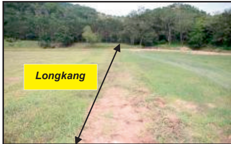
Padang SMK Dato' Undang Musa Al-Haj, Negeri Sembilan - Longkang Saliran Air Telah Ditutupi Tanah Dan Lumpur (10.12.2012)
