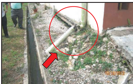
SMK Sebauh, Bintulu - Berlaku Pemendapan Tanah Berterusan (10.10.2012)
