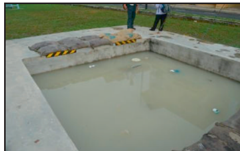
Litar Merempuh Halangan (Fasa 1) - Air Di Kolam Tarzan Swing Yang Kotor Tidak Dapat Diganti Memandangkan Discharge Outlet Tidak Disediakan (26.03.2013)
