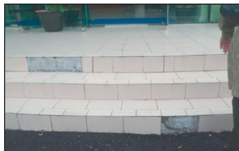
Bangunan Markas SMART (Fasa 2) - Jubin Di Anjung Tercabut (26.03.2013)
