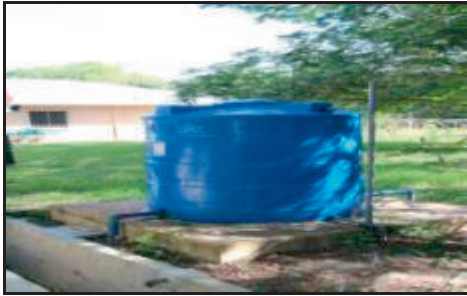
Tandas SMK Lajau, W.P. Labuan - Tangki Air Bagi Tujuan Mengumpul Air Untuk Disedut Ke Tandas (18.12.2012)
