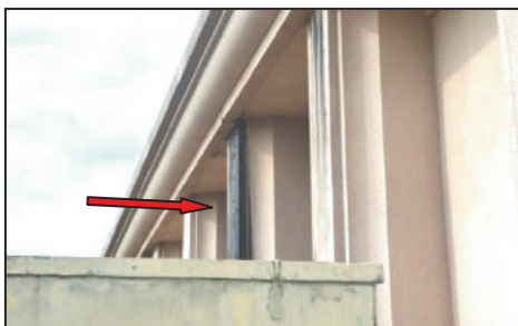
Aras Bumbung - Kemas Pada Tiang Dan Gutter Berlumut (21.01.2013)
