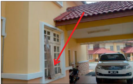
Kwarters SMART, Banglo Permata (Fasa 1) - Gutter Yang Tidak Dipasang Bagi Mengelakkan Aliran Hujan Dari Bumbung Terus Ke Tingkap Menyebabkan Daun Tingkap Kayu Reput (25.03.2013)
