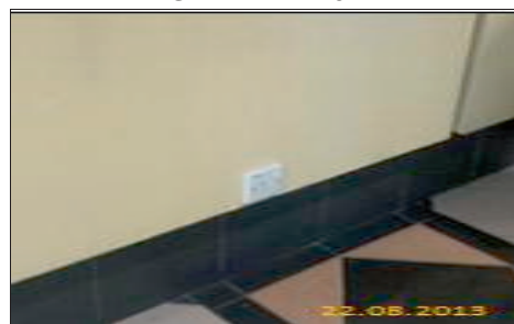
Kafeteria, Aras Tanah -Tindakan Telah Diambil (Sumber : BPH - 02.09.2013)
