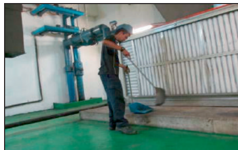
Bilik AHU Berdekatan Tangga Kecemasan No.22, Aras 2 - Tindakan Telah Diambil (Sumber Gambar: BPH 26.08.2013)
