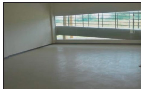
Rumah Kelab (Fasa 2) - Gimnasium Yang Kosong Dan Tidak Digunakan (26.03.2013)
