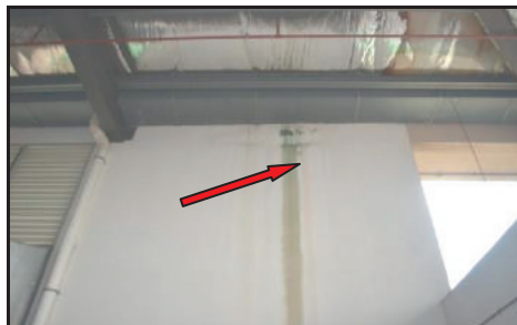
Aras Bumbung - Kesan Resapan Air Pada Dinding Menyebabkan Air Meleleh Dan Bertakung Di Lantai (21.01.2013)
