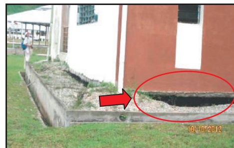
SMK Sebauh, Bintulu - Berlaku Pemendapan Tanah Berterusan (10.10.2012)
