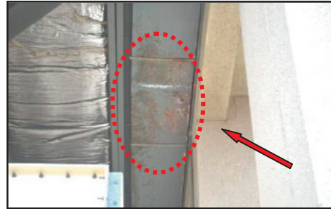
Aras Bumbung - Gutter Jenis 'Galvanised Iron' Berkarat (21.01.2013)
