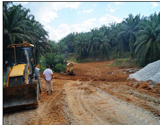
GAMBAR 8.21 Jalan Pertanian Yang Runtuh Dan Sedang Dalam Proses Pembaikan
