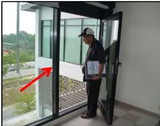
GAMBAR 2.28 Penggunaan Pintu Tidak Mempunyai Landing Area Atau Koridor
