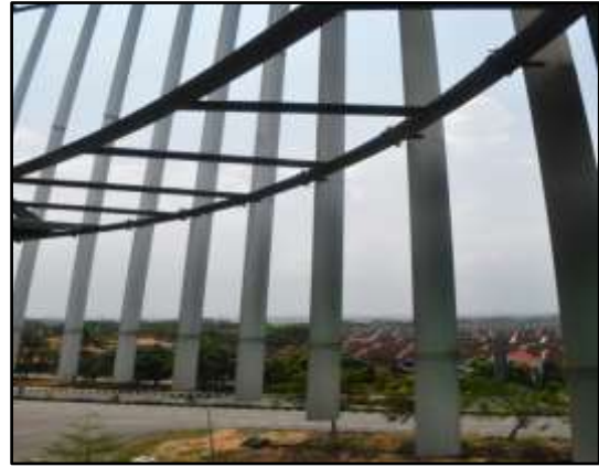
GAMBAR 2.4 Kerangka Vertical Fin
