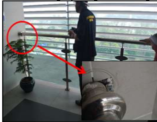
GAMBAR 2.38 Railing Diikat Hanya Menggunakan 2 Skru Yang Dipasang Pada Dinding
