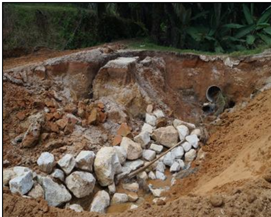
GAMBAR 8.21 Jalan Pertanian Yang Runtuh Dan Sedang Dalam Proses Pembaikan
