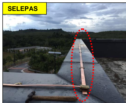
GAMBAR 6.18 Pengikat Copper Tape Dan Copper Tape Setelah Dipasang Semula
