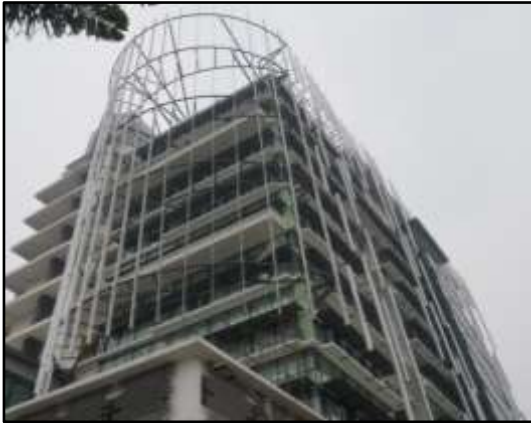
GAMBAR 2.3 Struktur Vertical Fin
