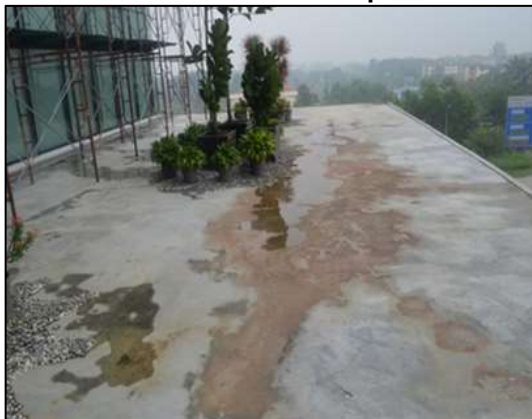
GAMBAR 2.33 Lantai Kawasan Landskap Berkarat
