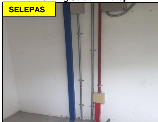
GAMBAR 6.6 Trunking Setelah Ditungkup
