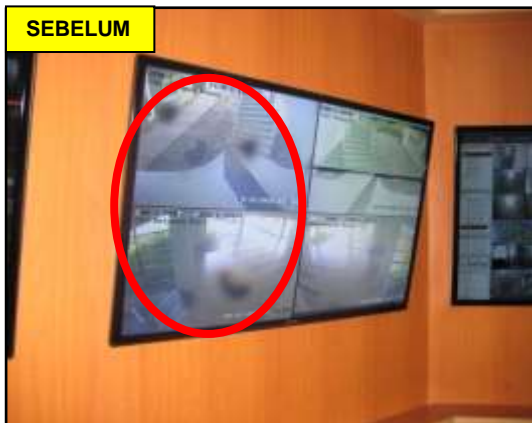
GAMBAR 4.10 Kesan Kotoran Pada Skrin CCTV Menghalang Paparan Imej
