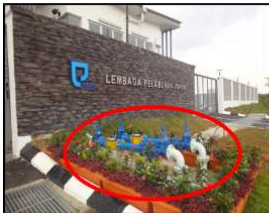
GAMBAR 2.26 Lokasi Paip Mengganggu Imej Korporat Dan Fasad Bangunan
