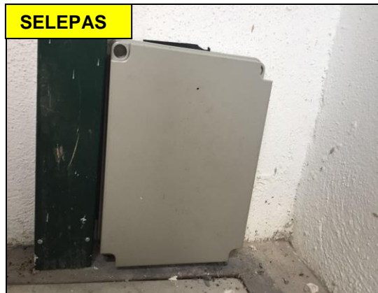
GAMBAR 6.4 Incoming Cable Selepas Ditungkup
