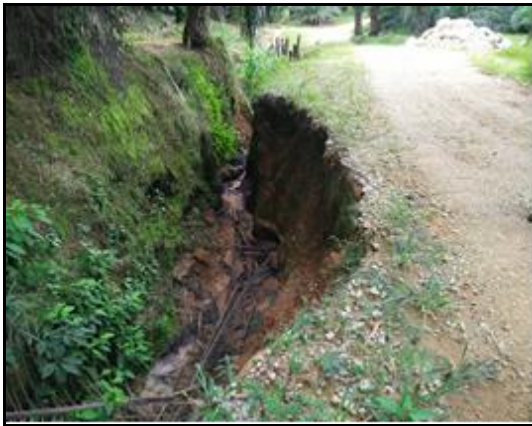
GAMBAR 8.17 Hakisan Tanah Di Jalan Pertanian Disebabkan Aliran Air Di Kawasan Parit Yang Bercerun
