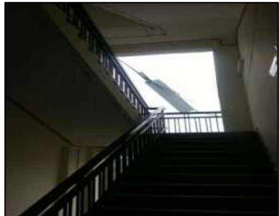
GAMBAR 2.45 Metal Cladding Tercabut (Pandangan Dari Dalam Bangunan)
