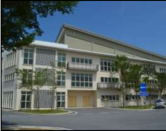
Lokasi : Bangunan Allied Health Tarikh : 3 November 2015
