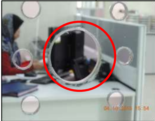
GAMBAR 2.35 Potongan Kaca Tidak Kemas Di Kaunter Bayaran
