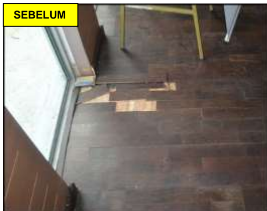
GAMBAR 2.15 Timber Flooring Yang Rosak Dan Tercabut
