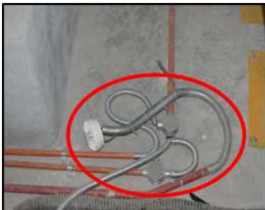
GAMBAR 2.39 Laluan Konduit Tidak Diikat Dengan PVC Fleksibel
