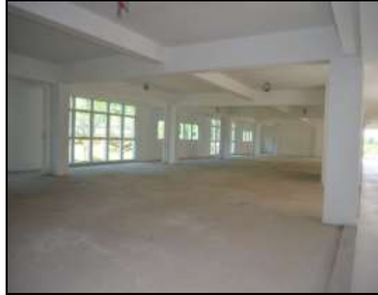
Lokasi : Bangunan Allied Health Tarikh : 3 November 2015
