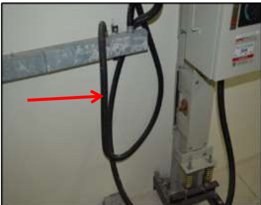
GAMBAR 2.25 Pembuluh Mudah Lentur Tidak Menggunakan Bahan Jenis Besi
