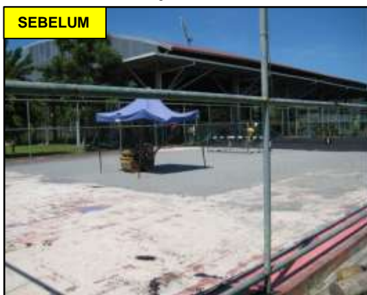
GAMBAR 4.16 Kerja Mengorek Permukaan Premix Sedia Ada Bagi Gelanggang Tenis Sedang Dijalankan
