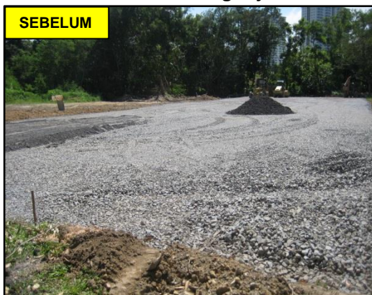
GAMBAR 4.14 Kerja Menghampar Batu Batan Crusher Run Sedang Dijalankan
