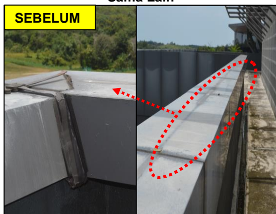
GAMBAR 6.17 Pengikat Copper Tape Telah Hilang Dan Copper Tape Tidak Bercantum Antara Satu Sama Lain
