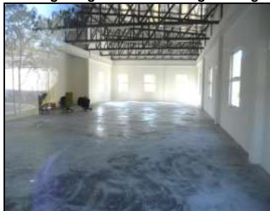
Lokasi : Bangunan Taska Pusat Rehabilitasi PERKESO Tarikh : 3 November 2015
