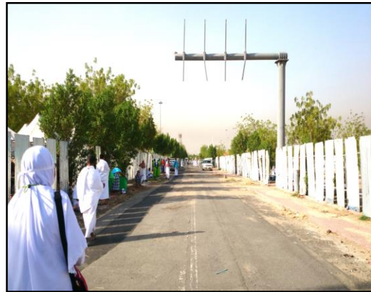
GAMBAR 9.12 Dinding Maktab Hanya Ditutup Dengan Zink
