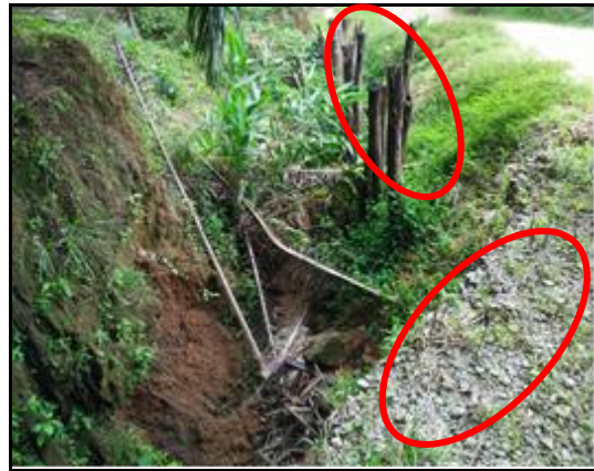
GAMBAR 8.18 Kayu Bakau Dan Batu Digunakan Untuk Menghalang Hakisan Merebak
