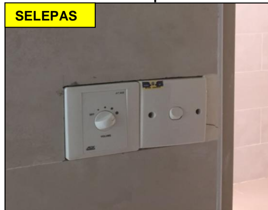
GAMBAR 6.10 Pemasangan Suis Setelah Ruang Terbuka Ditutup
