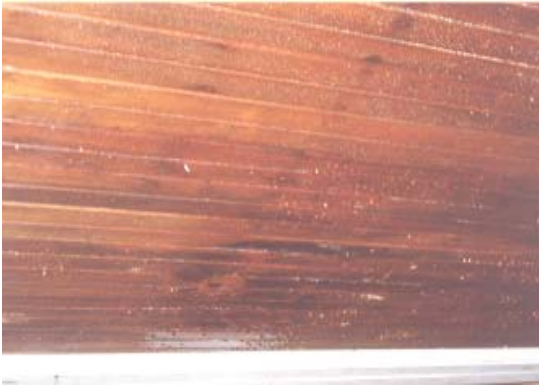
Resapan Air Di Siling Wad Orthopedic
