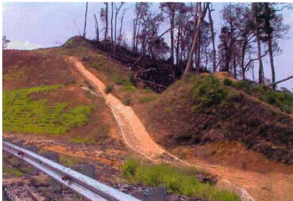
Pembersihan Tanah Oleh Pekebun Di Atas Cerun Di Rn 33+340 (Sebelah Kanan Jalan)
