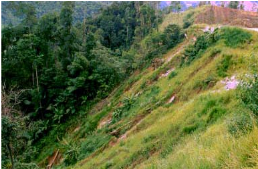
Pembinaan Cerun Dilakukan Secara End-Tipping
