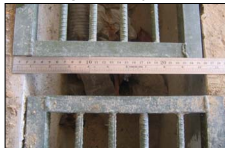
Penutup Longkang Tidak Sepadan Dengan Saiz Longkang
