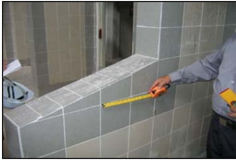
Ukuran Jubin Yang Berbeza Dengan Spesifikasi Kontrak - 21 Jun 2007
