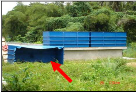
Projek Ternakan Udang Galah Kampung Luar, Baling, Kedah - Tangki Fiber Yang Pecah
