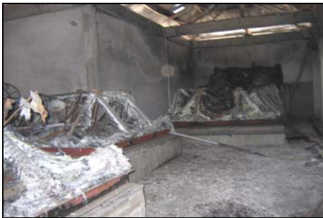
Tangki Air Fiber Di Atas Paling Atas Yang Hangus Terbakar - 25 April 2007
