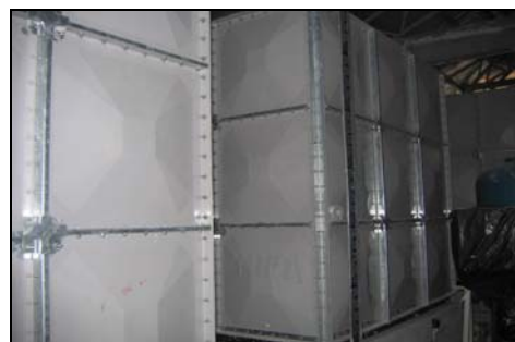
Kontraktor Penyelamat Telah Menjalankan Kerja-kerja Penggantian Tangki Air Yang Terbakar - 27 November 2007
