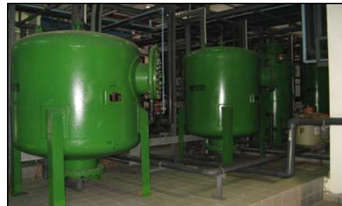
Stesen Jana Kuasa Pasir Gudang YTL Power Generation Sdn. Bhd. - Tangki Penyulingan Air
