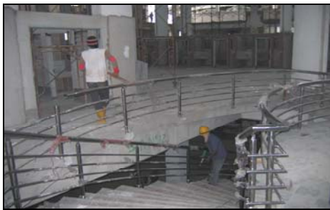
Kerja-kerja Kemasan Tangga Dan Pemasangan Handrail Di Bahagian Dalam Bangunan Sedang Dilakukan - 27 November 2007
