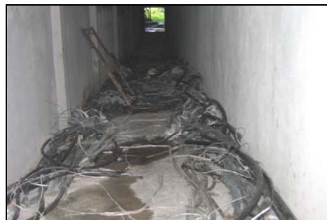
Logam Kabel Elektrik Yang Dicuri Dan Sisa Penebat Yang Dibiarkan Bertaburan - 25 April 2007
