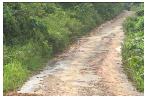
Jalan Raya Ke Taman Negara Endau Rompin, Pahang - Laluan Jalan Raya Berturap Jenis Pro-Base Yang Digunakan Telah Pecah Dan Berlubang
