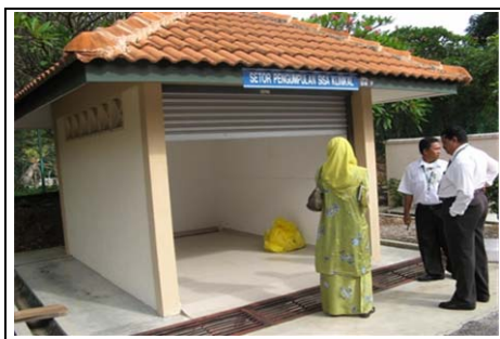
Klinik Kesihatan Port Dickson - Stor Sisa Klinikal Berasingan Dengan Bangunan Klinik
