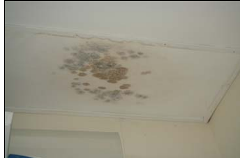
Pusat Sumber Palong 9, Jempol, Negeri Sembilan - Siling Diresapi Air
