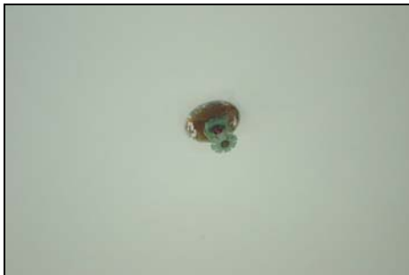
Ruang Utama Kompleks CIQ - Sprinkler Untuk Sistem Pencegah Kebakaran Yang Dipasang Telah Berkarat
