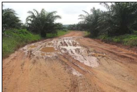
Jalan Raya Ke Taman Negara Endau Rompin, Pahang - Laluan Jalan Raya Berturap Jenis Pro-Base Yang Digunakan Telah Pecah Dan Berlubang
