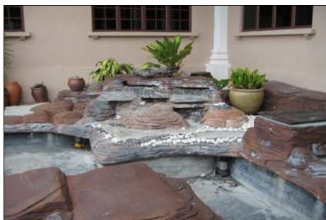
Lokasi A Keadaan Kolam Yang Tidak Berfungsi
