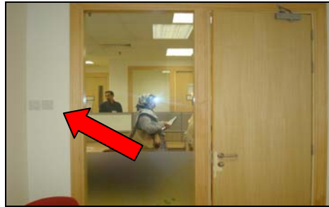
Rangka Pintu Direka Bersekali Dengan Kerangka "Frame" Menyebabkan Suis Lampu Terpaksa Dipasang Di Dinding Bersebelahan Dinding Kaca
