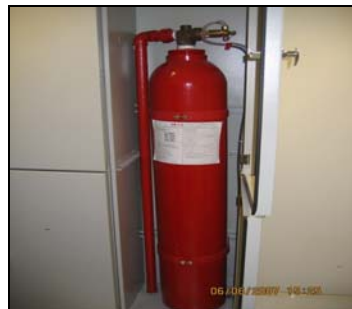
Sistem Pencegah Kebakaran Fe13
