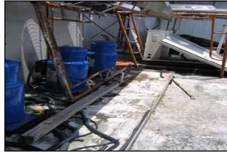
Kesan Aktiviti Vandalisme Ke Atas Kelengkapan Penyaman Udara - 25 April 2007
