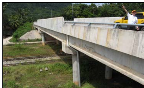
Jambatan Dabong Merentasi Laluan Kereta Api
