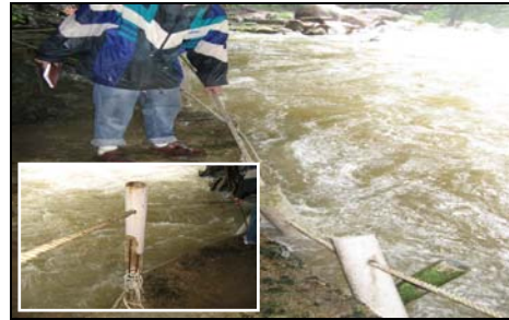
Railing Di Kawasan Sungai Lasir, Tasik Kenyir, Terengganu - Palang Pada Railing Bertali Musnah Akibat Arus Sungai Yang Kuat Pada Musim Tengkujuh
