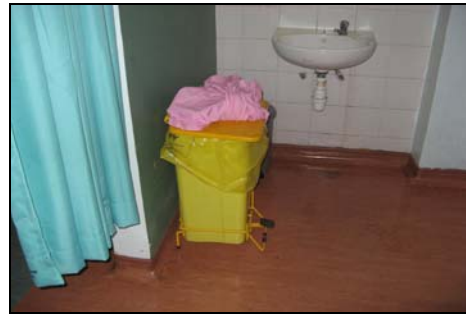
Wad Obstetrik Dan Ginekologi, Hospital Melaka - Pakaian Diletak Di Atas Tong Kuning
