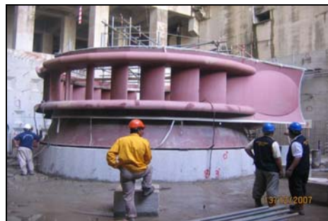
Kerja Pemasangan Komponen Turbin
