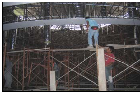
Proses Kemasan Di Bahagian Dewan Serba Guna Di Tingkat Paling Atas Bangunan Kompleks Sedang Dijalankan - 27 November 2007
