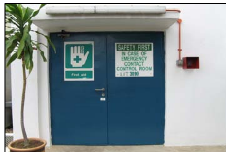
YTL Power Generation Sdn. Bhd. - Pintu Keluar Kecemasan Di Stesen Jana Kuasa Pasir Gudang
