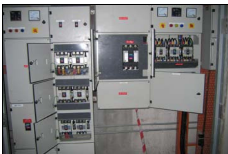
Kotak Fius Yang Rosak Telah Diperbaiki Dan Digantikan Dengan Komponen Yang Baru - 27 November 2007
