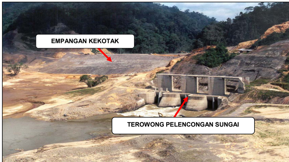
Terowong Pelencongan Sungai Dan Empangan Kekotak
