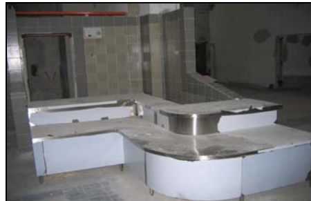
Kontraktor Penyelamat Telah Menggantikan Kemasan Di Gerai Dengan Bahan Logam Mengikut Spesifikasi Kontrak - 27 November 2007
