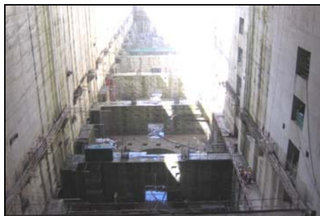
Lokasi Turbin Yang Akan Dipasang
