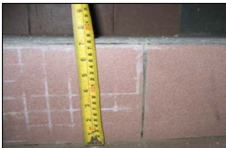
Perbezaan Ketinggian Anak Tangga Di Basement Sebanyak 1 Inci - 21 Jun 2007
