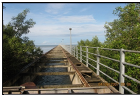
Railing Sepanjang 2 Kilometer Menuju Ke Pam Air
