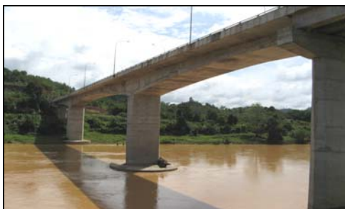
Jambatan Dabong Merentasi Sungai Galas
