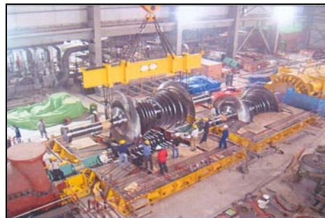
Stesen Jana Kuasa Jimah Energy Ventures Sdn. Bhd. - Generator Rotor Dalam Pemasangan
