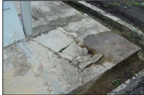
Pusat Sumber Kampung Binjal, Kayang, Kangar, Perlis - Simen Luar Yang Telah Pecah
