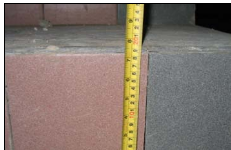
Perbezaan Ketinggian Anak Tangga Di Basement Sebanyak 1 Inci - 21 Jun 2007
