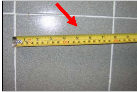
Ukuran Jubin Yang Berbeza Dengan Spesifikasi Kontrak - 21 Jun 2007
