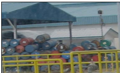
Stesen Jana Kuasa Lumut Segari Energy Ventures Sdn. Bhd. - Longgokan Tong-tong Minyak/Bahan Kimia Yang Telah Digunakan
