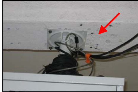
SMK(P) Raja Zarina, Pelabuhan Klang, Selangor Lokasi : Bilik Darjah - Tiga Skru Dipasang Kepada Bracket Projektor LCD
