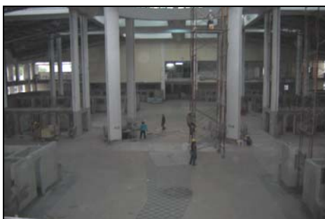
Kerja-kerja Pembaikan Dan Pengemasan Di Dalam Bangunan Kompleks - 27 November 2007
