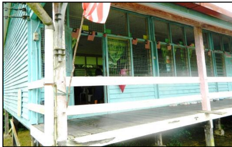
SK Ulu Sungai Naman, Julau, Sarawak - Bilik Darjah Bangunan Kayu Yang Dicapadangkan Untuk Projek Ubah Suai Tidak Sesuai (06.09.2012)
