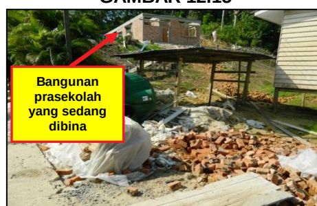
SK Nanga Selangau, Sibu, Sarawak - Bangunan Baru Prasekolah Yang Sedang Dibina Di Kawasan Yang Lebih Tinggi (03.09.2012)
