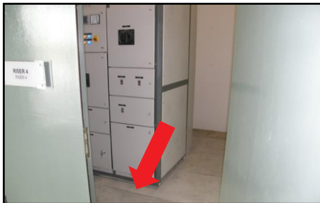
Atas Bawah - Bilik Suis (Riser 4) - Tiada Pelapik Getah Diletakkan Di Hadapan Papan Suis (12.06.2012)
