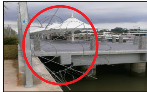
Jeti Ketibaan Dan Pelepasan - Pagar Keselamatan Telah Disambung Terus Dengan Menyediakan Safety Spike Antara Hujung Jeti Dengan Anti Climb Fencing (06.11.2012)
