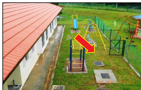
SK Pekan Layang-layang, Kluang, Johor - Contoh Kerja Turfing/Menanam Rumput Yang Meliputi 90% Permukaan Tanah (11.07.2012)
