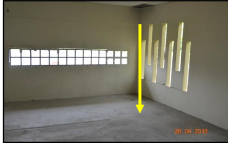
Taman Kejiranan Air Panas - Kemasan Lantai Surau Diperbuat Daripada Lepaan Simen (28.09.2012)
