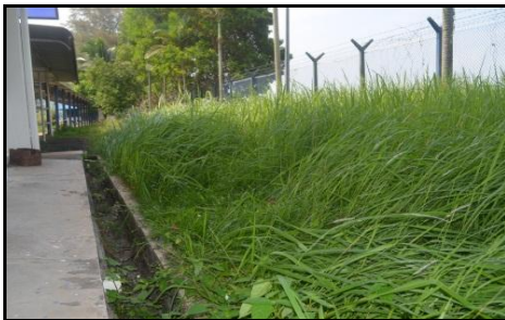
Markas Operasi PGM Wilayah 3, Kemaman - Rumput/Lalang Dibelakang Bangunan Pejabat (12.06.2012)
