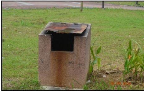
Taman Kejiranan Air Panas, Setapak - Penutup Tong Sampah Diperbuat Daripada Besi Yang Tidak Berkualiti Dan Berkarat (28.09.2012)
