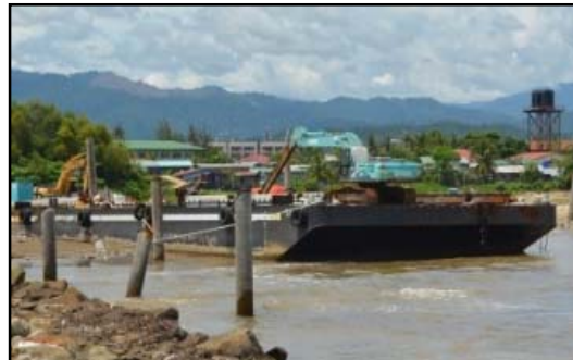
Kawasan Pembinaan Precision Approach Lighting - Barge Yang Digunakan Untuk Kerja-Kerja Piling (11.07.2012)
