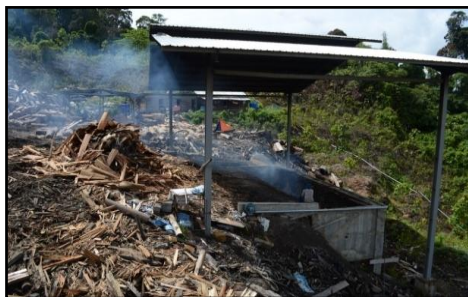
Kawasan Pelupusan Sisa Balak Dan Biomas - Green Burner (07.11.2012)
