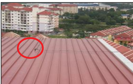
Aras Bumbung Menara Satu - Pemasangan Perlindungan Kilat Tidak Menepati Piawaian Kerana Tiada Pemasangan "Air Terminal" Di Bahagian Atas Bumbung Bangunan (27.11.2012)
