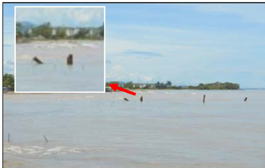
Kawasan Pembinaan Precision Approach Lighting - Piling Untuk Precision Approach Lighting Yang Telah Dibina Oleh Pihak Kontraktor (11.07.2012)
