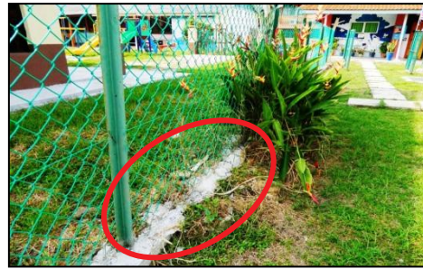
SK Dato' Manan, Kuala Selangor, Selangor - Kerja Bebendul Untuk Pagar Tidak Kemas (09.08.2012)
