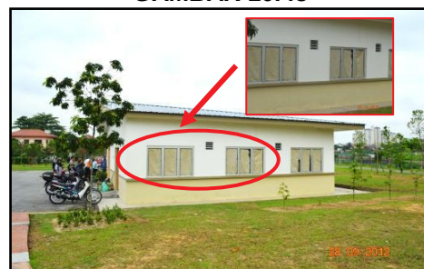
Taman Kejiranan Air Panas - Tingkap Bercermin Hanya Ditutup Dengan Kertas Yang Mudah Dibolosi (28.09.2012)
