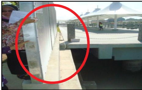
Jeti Ketibaan Dan Pelepasan - Pagar Keselamatan Tidak Disambung Terus (12.06.2012)
