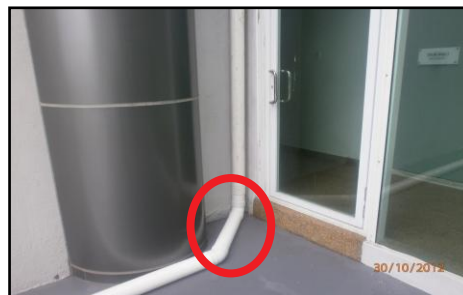
Aras Bumbung Rata - Salur Paip Hujan/RWDP Telah Dipanjangkan Sehingga Terus Ke Gutter (30.10.2012)
