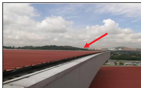
Aras Bumbung Menara Satu - Pemasangan Perlindungan Kilat Tidak Menepati Piawaian Kerana Tiada Pemasangan "Air Terminal" Di Bahagian Atas Bumbung Bangunan (27.11.2012)
