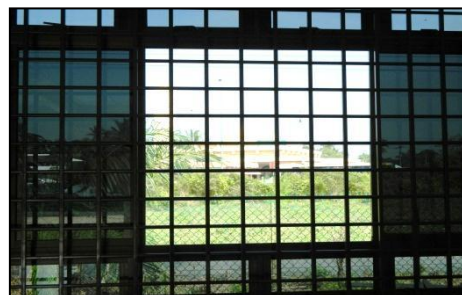
SK Dato' Manan, Kuala Selangor, Selangor - Jeriji Besi Telah Dipasang Bagi Projek Prasekolah Fasa 2 (09.08.2012)
