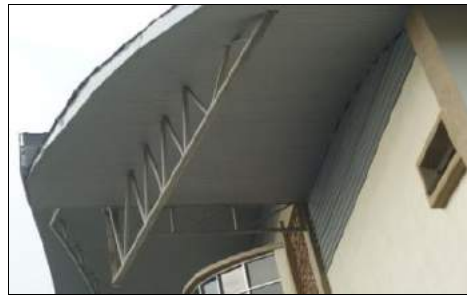
PMK Sungai Pulai, Johor - Pemasangan Aluminium Strip Siling Telah Siap Sepenuhnya (Sumber: JKR)
