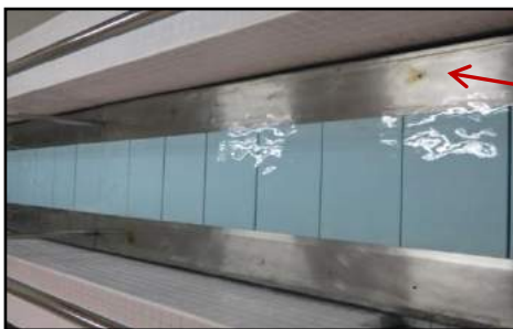
Jabatan Fisioterapi, HAT Terendak - Pelantar Stainless Steel Berkarat Disebabkan Kandungan Klorin Yang Tidak Seimbang (09.04.2013)
