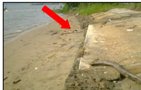
PMK Pengkalan Kubor, Kelantan - Ramp Tergantung Semasa Air Surut (24.06.2013)
