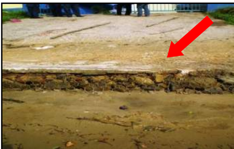
PMK Pengkalan Kubor, Kelantan - Ramp Tergantung Semasa Air Surut (24.06.2013)
