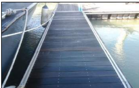
PMK Weld Quay, Pulau Pinang - Jejari Pontun Telah Dibaiki Pada 06.09.2013 (Sumber: Unit Marin Weld Quay)
