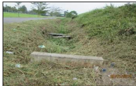
Terowong Kenderaan Ringan (Kawasan Vehicular Box Culvert) - Rumput Telah Dipotong Dan Disenggarakan (09.01.2013)
