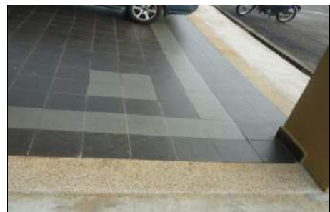
PMK Sungai Pulai, Johor - Lantai Di Bahagian Lobi Depan Telah Dibaiki (Sumber: JKR)
