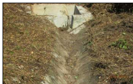
BR 15 Padang Sanai - Longkang Dan Sump Pit Telah Disenggarakan Dengan Baik (12.01.2014)
