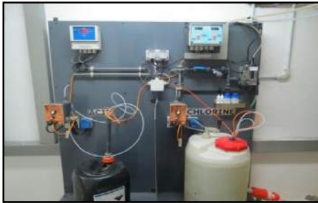
Jabatan Fisioterapi, HAT Terendak - Peranti Yang Digunakan Untuk Mengawal/ Memantau Campuran Klorin (09.04.2013)
