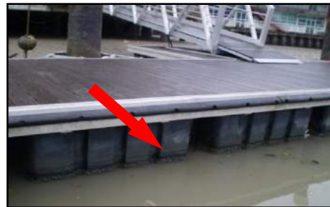
PMK Kuala Perlis, Perlis - Teritip Di Tiang Jeti Dan Pontun (12.06.2013)
