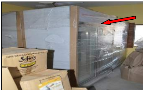
Stor Pusat, Penjara Pusat Kajang - Display Chiller Yang Tidak Digunakan (13.05.2013)
