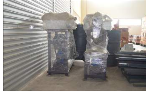
Stor Utama, Penjara Bentong - Revolving Oven Yang Masih Belum Dipasang (21.05.2013)
