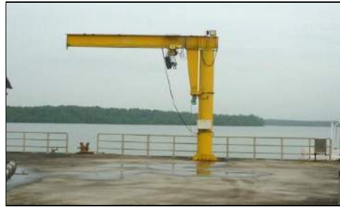
PMK Sungai Pulai, Johor - Kren Angkut Telah Dibaiki (Sumber: JKR)
