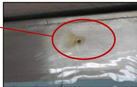
Jabatan Fisioterapi, HAT Terendak - Pelantar Stainless Steel Berkarat Disebabkan Kandungan Klorin Yang Tidak Seimbang (09.04.2013)
