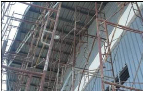
PMK Sungai Pulai, Johor - Kerja Meletakkan Aluminium Strip Siling Pada Bumbung Bengkel Terbengkalai (08.10.2013)
