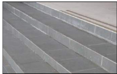
PMK Sungai Pulai, Johor - Tangga Bangunan Pejabat Depan Telah Dibaiki (Sumber: JKR)
