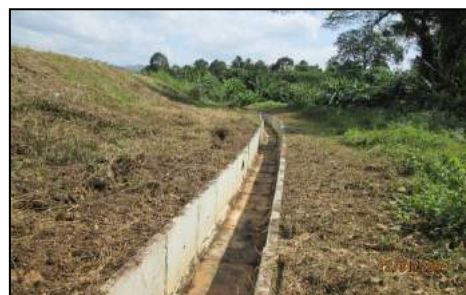
BR 15 Padang Sanai - Longkang Telah Disenggarakan Dengan Baik (12.01.2014)
