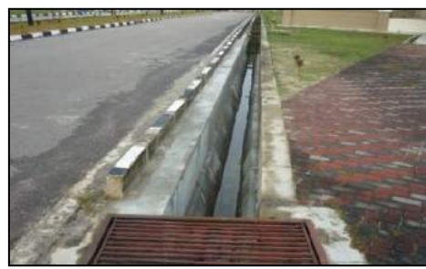
PMK Sungai Pulai, Johor - Tembok Longkang Telah Dibaiki (Sumber: JKR)
