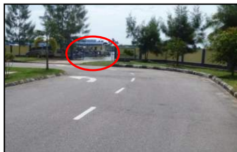
PMK Pengkalan Kubor, Kelantan - Kedudukan Ramp Bersebelahan Selekoh Menyukarkan Laluan Untuk Mengangkut Bot Keluar/Masuk (24.06.2013)
