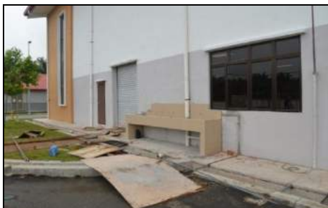
Bengkel Teknologi Kimpalan, ADTEC Jerantut - Kerja Memasang Stainless Steel Single Bowl Single Drainer Untuk Mencuci Dan Membasuh Tangan Bernilai RM8,680 (29.05.2013)
