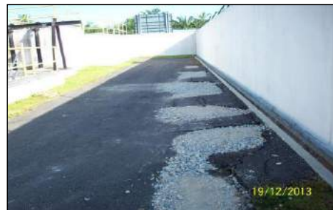
Sewerage Treatment Plant - Kawasan Mendap Diletakkan Crusher Run Sebelum Kerja Premix Dilakukan (Sumber: JKR - 20.12.2013)
