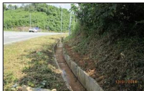
Jalan Berhadapan Tangki Air SADA, Padang Sanai - Longkang Telah Disenggarakan Dengan Baik (13.01.2014)
