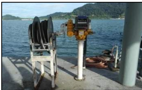
PMK Lumut, Perak - Tangki Minyak Yang Tidak Digunakan (11.09.2013)
