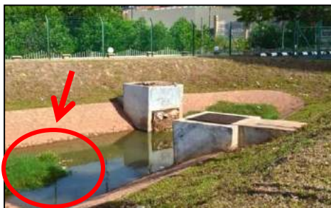
Detention Pond - Terdapat Tumbuhan Di Dalam Detention Pond (19.06.2013)
