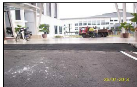
Lobi, Blok Pentadbiran - Kawasan Mendap Telah Siap Dibaiki Dengan Menurap Premix (Sumber: JKR - 20.12.2013)
