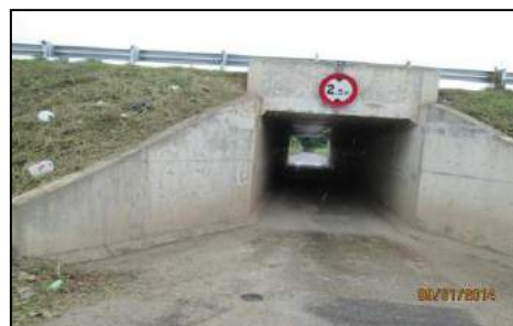
Terowong Kenderaan Ringan (Kawasan Vehicular Box Culvert) - Tiada Lagi Masalah Air Bertakung Di Atas Jalan (09.01.2014)
