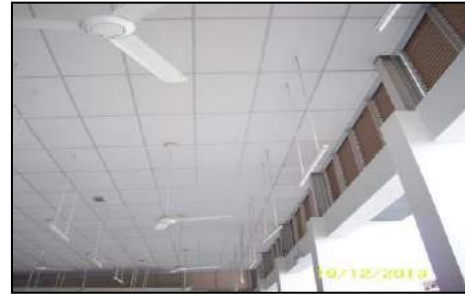
Kantin - Pemasangan Klip Di Kawasan Terlibat Telah Dilakukan (Sumber: JKR - 20.12.2013)
