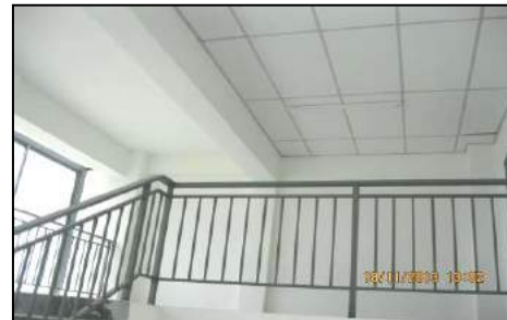
Koridor Di Luar Bilik Tangki Air - Pemasangan Klip Di Kawasan Terlibat Telah Dilakukan (Sumber: JKR - 20.12.2013)
