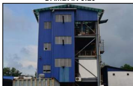
Syarikat Nasmtech Technology Sdn. Bhd., Bukit Rambai, Melaka - Menara Operasi Carbonator (17.05.2013)
