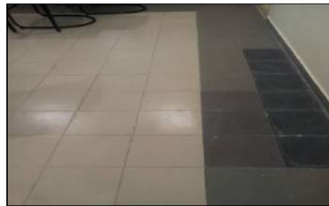
PMK Sungai Pulai, Johor - Jubin Lantai Bangunan Telah Dibaiki (Sumber: JKR)
