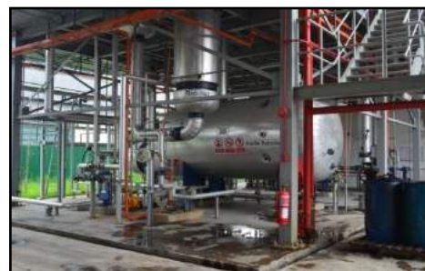
Syarikat Daya Clarimax Sdn. Bhd., Pelabuhan Klang, Selangor - Dandang Pemanasan Untuk Sistem Penyulingan (30.8.2013)
