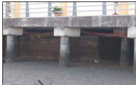
PMK Kuala Perlis, Perlis - Kabel Elektrik Telah Disenggara
