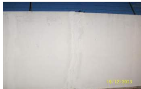
Sewerage Treatment Plant - Kerja Plaster Dan Mengecat Telah Dilakukan (Sumber: JKR - 20.12.2013)
