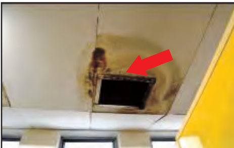
SMAP Bentong, Bentong, Pahang - Resapan Air Di Siling Tandas Asrama Lelaki Akibat Kebocoran (03.07.2013)
