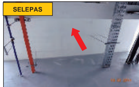
Bilik Mekanikal (VRV), Aras 3 - Lepaan Simen Telah Dibuat Pada Bahagian Bawah Lantai Ke Lobi Lif (Sumber JKR - 19.03.2014)
