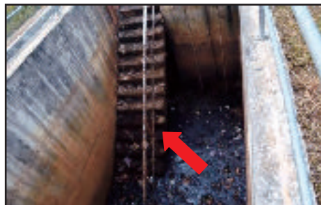
SMS Banting, Banting, Selangor - Lualan Tangga Untuk Penyenggaraan Loji Rawatan Kumbahan Tersumbat Dipenuhi Najis Akibat Pam Yang Tidak Berfungsi (26.06.2013)
