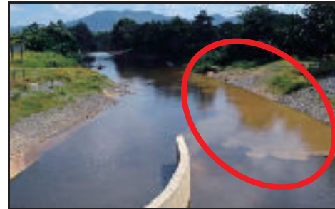
Serian Regional Water Supply Phase I - Enapcemar Yang Dilepaskan Terus Ke Sungai Batang Sadong (24.07.2013)
