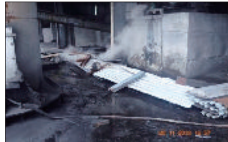
Kilang Sawit Nasaruddin, Perak -Paip Yang Bocor Ditutup Dengan Atap (20.11.2013)
