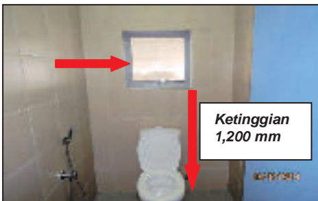
Tandas Dan Bilik Mandi Wanita, Aras 3, Bangunan Pentadbiran - Ketinggian Pemasangan Tingkap Yang Tidak Sesuai Akan Menjejaskan Keselesaan Kepada Peguna Wanita Di Mana Ketinggian Antara Lantai Dengan Tingkap Adalah 1,200 mm. (19.03.2014)
