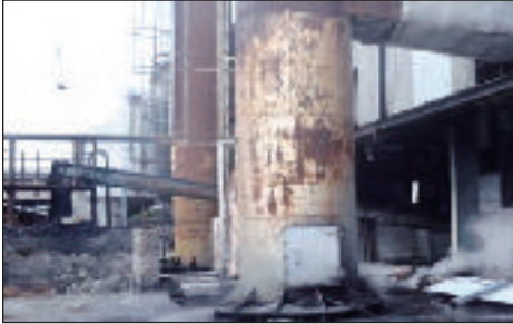
Kilang Sawit Nasaruddin, Perak - Peralatan Yang Memerlukan Penyelenggaraan (20.11.2013)
