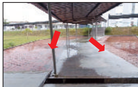
SMS Batu Pahat, Batu Pahat, Johor - Tiada Longkang Di Kiri Dan Kanan Laluan Pejalan Kaki Menghala Ke Surau Menyebabkan Air Bertakung Dan Lantai Licin Apabila Hujan (28.08.2013)
