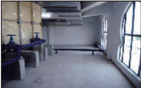
Tangki Air, Aras 8 - Tiada Pembinaan Floor Trap (29.10.2013)
