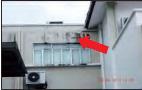
SMS Batu Pahat, Batu Pahat, Johor - Air Meresap Masuk Ke Dalam Pusat Sumber Melalui Ruang Dinding Yang Terbuka (28.08.2013)
