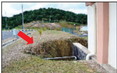
SMS Bentong, Bentong, Pahang - Mendapan Tanah Yang Serious Di Sebelah Astaka (03.07.2013)
