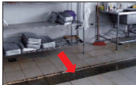
SMS Batu Pahat, Batu Pahat, Johor - Kedalaman Internal Scupper Drain Tidak Mengikut Saiz Menyebabkan Air Mudah Melimpah Di Dapur Dewan Makan (28.08.2013)
