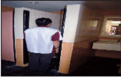
Bilik Dorm Lelaki - Keluasan Tandas Adalah Sempit Yang Berukuran 61 cm. (29.10.2013)
