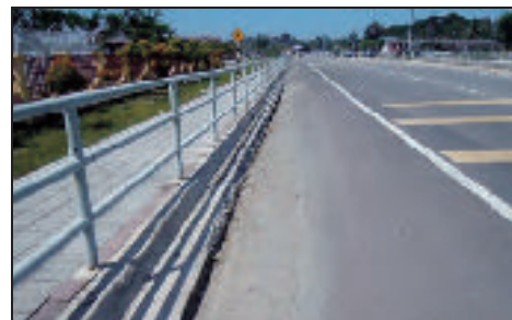
Chainage 1000 - Tindakan Pembaikan Telah Dilaksanakan Oleh Pihak Kontraktor (Sumber: JKR - 02.04.2014)
