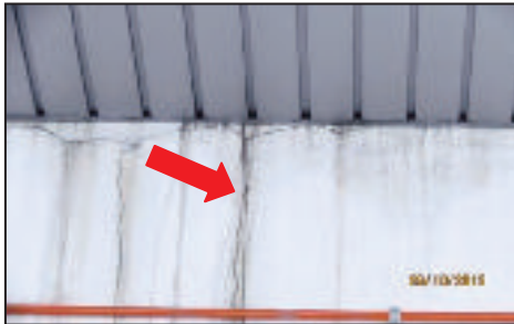
Tempat Letak Kereta - Aras 4 - Kesan Lelehan Air Pada Permukaan Dinding Menyebabkan Kulat Terbentuk (29.10.2013)
