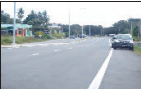
Chainage 0 dan 600 - Jalan Beralun (28.11.2013)
