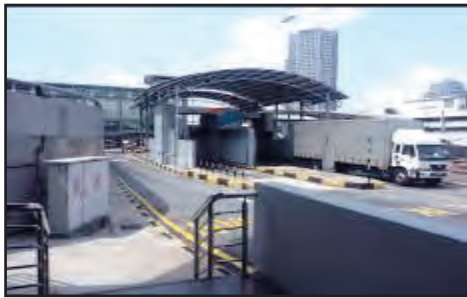
Kompleks CIQ, Bangunan Sultan Iskandar, Johor Bahru - Mesin Pengimbas Jenis Pass-Thru (27.08.2013)
