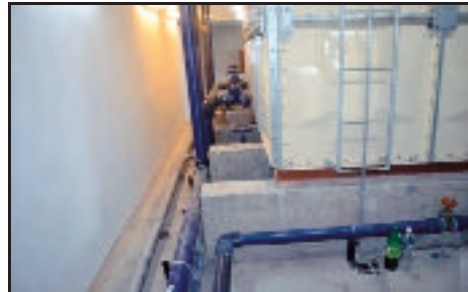
Tangki Air, Aras 8 - Tiada Pembinaan Floor Trap (29.10.2013)
