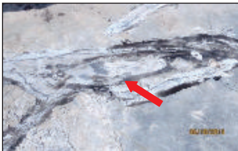
Aras Bumbung, Bangunan Pentadbiran - Keretakan Pada Permukaan Lantai Bumbung Konkrit Rata (30.10.2013)
