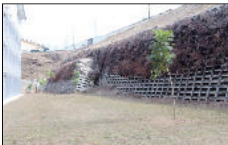
SMK Seremban 3, Seremban, Negeri Sembilan - Kerja Dinding Penahan RC Wall Dan Crib Wall Yang Tidak Kemas Kerana Dinding Penahan Kedua Diperlukan Untuk Menguatkan Struktur Dinding Penahan Pertama (29.08.2013)
