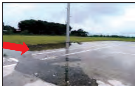
SMAP Bentong, Bentong, Pahang - Gelanggang Badminton Pecah Dan Menjadi Takungan Air Hujan (03.07.2013)
