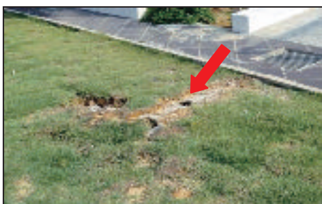
Kawasan Lanskap Pejalan Kaki, Hadapan Balai - Mendapan Di Kawasan Lanskap (30.10.2013)
