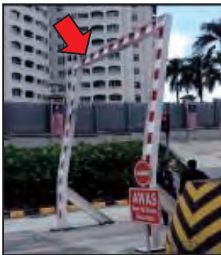
Laluan Eksport, Kompleks CIQ Bangunan Sultan Iskandar, Johor Bahru - Palang Laluan Mesin Pengimbas Bengkok Disebabkan Muatan Lori Melebihi Ketinggian Maksimum (29.08.2013)
