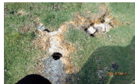
Kawasan Lanskap Pejalan Kaki, Hadapan Balai - Mendapan Di Kawasan Lanskap (30.10.2013)
