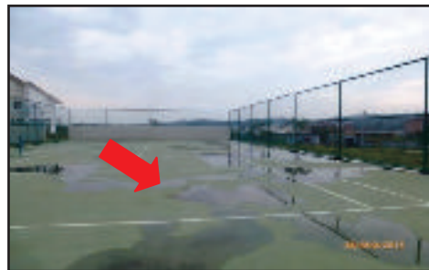
SMS Batu Pahat, Batu Pahat, Johor - Gelanggang Tenis Berlopak Dan Tidak Dibaiki (28.08.2013)
