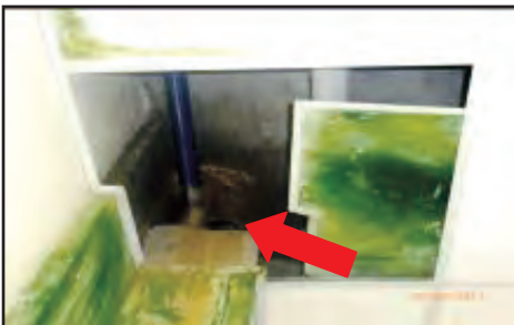
SMS Batu Pahat, Batu Pahat, Johor - Resapan Air Di Siling Tandas Asrama Perempuan Akibat Kebocoran (28.08.2013)
