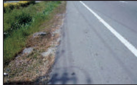
Chainage 700 - Tindakan Pembaikan Telah Dilaksanakan Oleh Pihak Kontraktor (Sumber : JKR - 02.04.2014)
