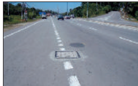
Chainage 2150 - Tindakan Pembaikan Telah Dilaksanakan Oleh Pihak Kontraktor (Sumber: JKR - 02.04.2014)
