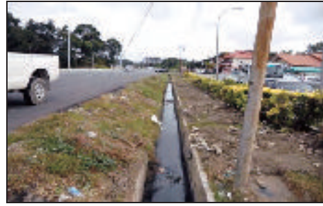
Chainage 600 - Tindakan Penyelenggaraan Telah Dilaksanakan (Sumber: JKR - 02.04.2014)
