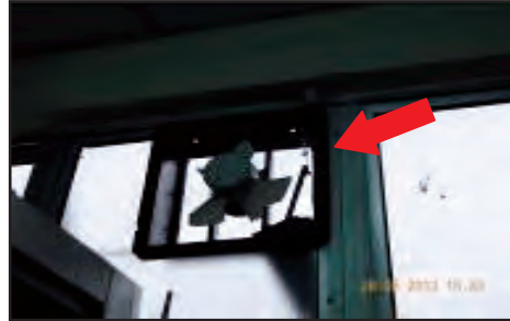
SMS Batu Pahat, Batu Pahat, Johor - Sebahagian Bilah Kipas Ekzos Telah Patah Akibat Terkena Cermin Tingkap Di Tandas Blok Pentadbiran (28.08.2013)
