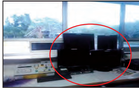
Tanjung Kupang, Johor - Mesin Pengimbas Rosak (24.10.2013)
