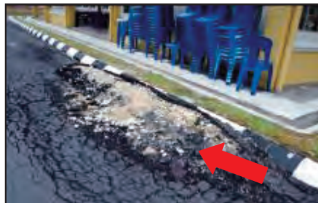
SMS Bentong, Bentong, Pahang - Jalan Telah Mendap Dan Merekah Bersebelahan Bangunan Kantin (03.07.2013)
