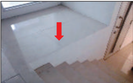
Aras 4, Bangunan Pentadbiran - Tiada Pelepar Direka Bentuk Dan Dipasang Pada Permukaan Lantai. Ini Boleh Mendatangkan Bahaya Kepada Pengguna (30.10.2013)
