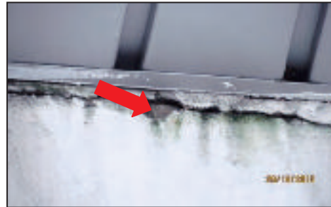
Tempat Letak Kereta - Aras 4 - Kesan Lelehan Air Pada Permukaan Dinding Menyebabkan Kulat Terbentuk (29.10.2013)
