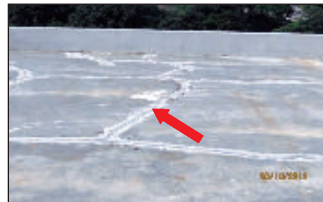
Aras Bumbung, Bangunan Pentadbiran - Keretakan Pada Permukaan Lantai Bumbung Konkrit Rata (30.10.2013)
