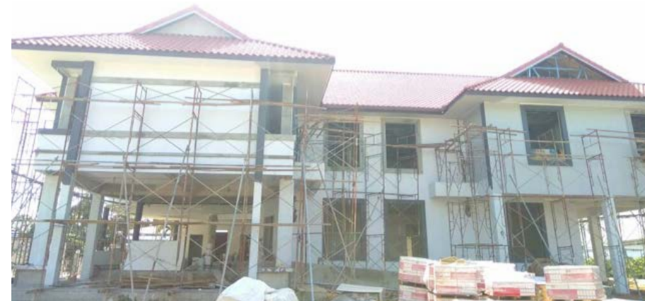
Kerja-kerja mengecat luar bangunan sedang dijalankan.
