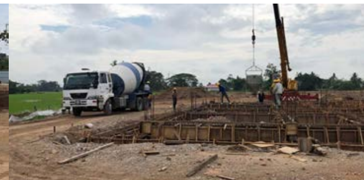
Gambar kerja-kerja Ground Beam sedang dijalankan di tapak bagi pembinaan baru bangunan Penyiaran RTM Perlis.
