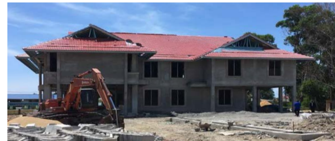
Gambar pembinaan lantai tingkat satu dan kerja pemasangan kerangka bumbung telah siap.
