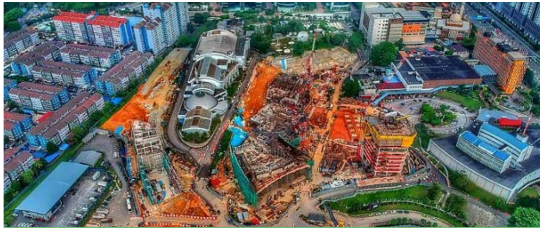
Pandangan keseluruhan kerja-kerja pembinaan di tapak bagi Pembangunan Semula Tapak Kompleks Angkasapuri melalui Drone – Ihsan RTM
