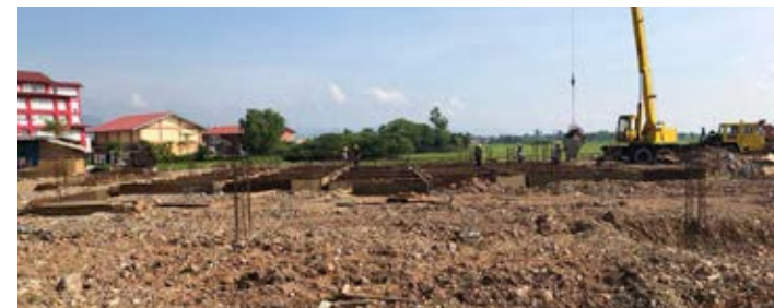
Gambar di tapak bagi pembinaan baru bangunan Penyiaran RTM Perlis.
