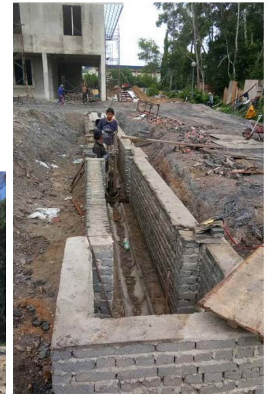
Kerja-kerja luar bangunan dan pembinaan longkang sedang dijalankan ditapak.
