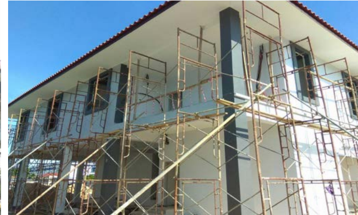
Kerja-kerja pembinaan sedang dijalankan di tapak projek.
