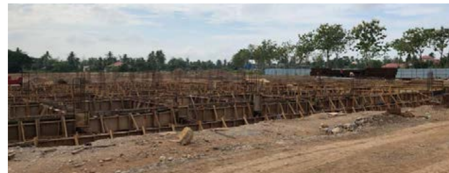
Gambar kerja-kerja Ground Beam sedang dijalankan di tapak bagi pembinaan baru bangunan Penyiaran RTM Perlis.
