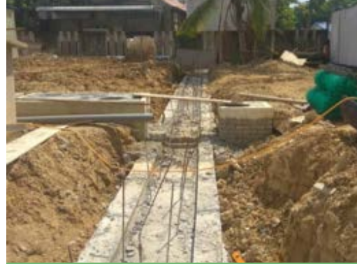
Kerja-kerja luar bangunan termasuk penyediaan longkang.
