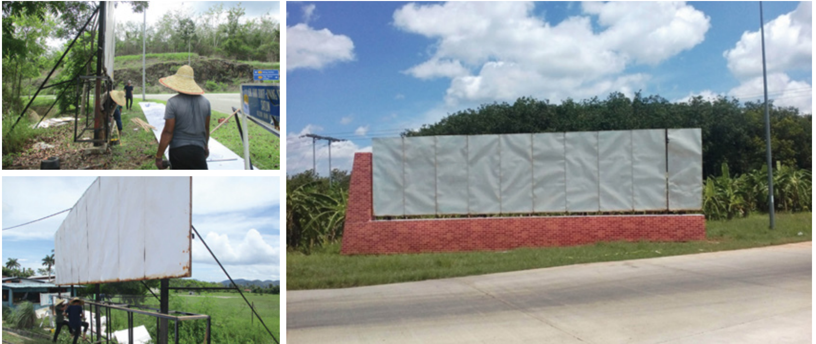
➤ Kerja-kerja penyelenggaraan struktur billboard bersaiz 10' X 40' di Simpang 3 Jalan Ladang Tebu ke Padang Besar, Perlis.
