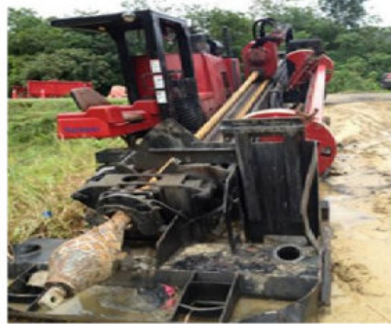
Mesin pemasangan kabel melalui kaedah Horizontal Directional Drilling (HDD)
