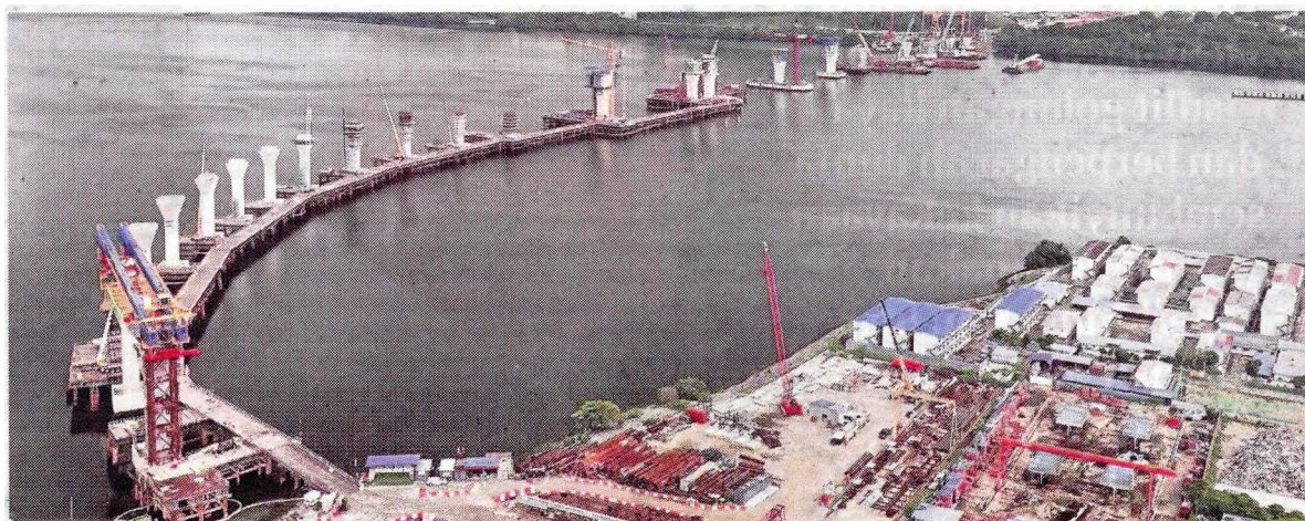
Anwar bersama Hsien Loong dijadual melawat projek pembinaan RTS Link yang menghubungkan Johor Bahru dan Singapura.
