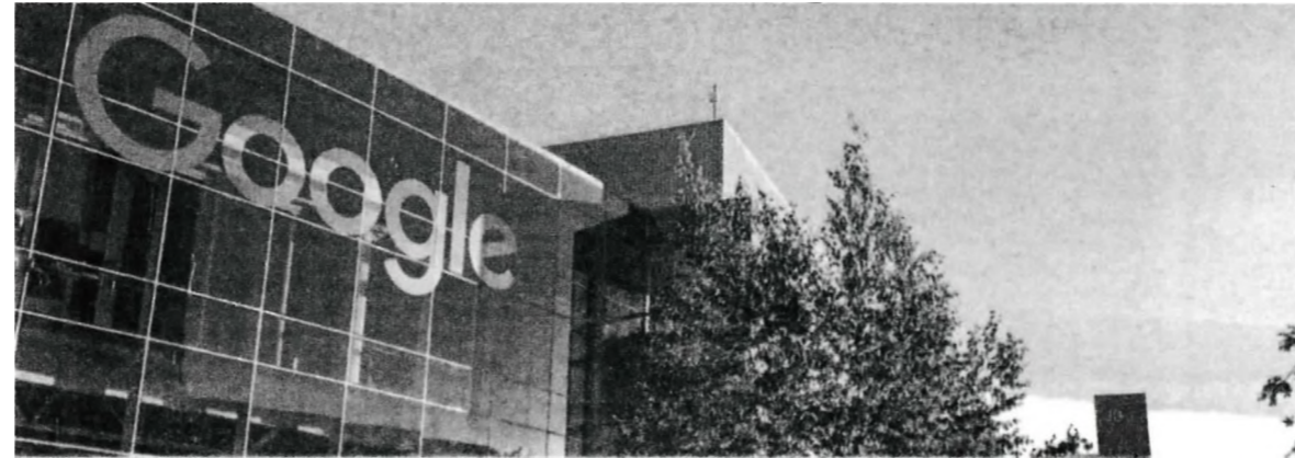
PFLABURAN Google di negara ini mampu mewujudkan sebanyak 26,500 peluang pekerjaan. - Gambar hiasan
