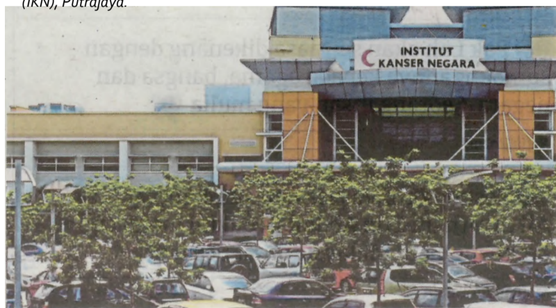
Institut Kanser Negara (IKN), Putrajaya.
