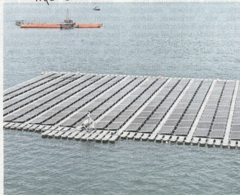
Projek Solar Terapung Hibrid Hidro (HHFS) dan Hab Hidrogen Hijau di Terengganu diluncurkan di Kuala Berang, semalam. (Foto BERNAMA)
