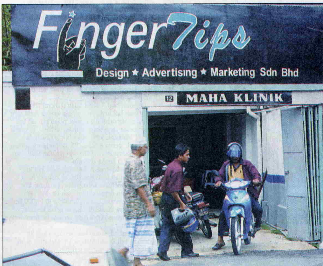
BANGUNAN asal Klinik Maha yang terletak di No 12 Pekan Melayu Alor Star.
