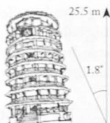
Menara Condong Teluk Intan
