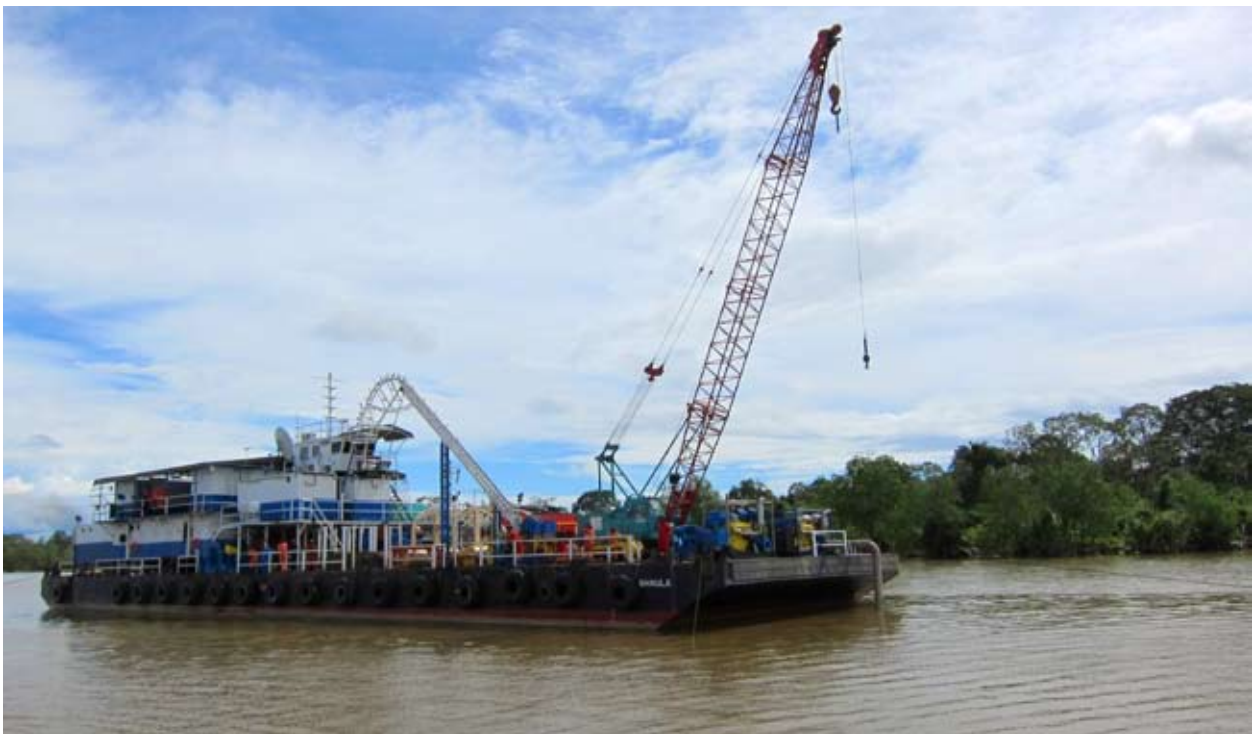
Kapal yang digunakan khas untuk memasang kabel dasar laut
