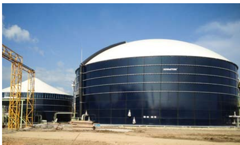
Loji biogas di Bintulu. Gambar foto ihsan conbio.info
