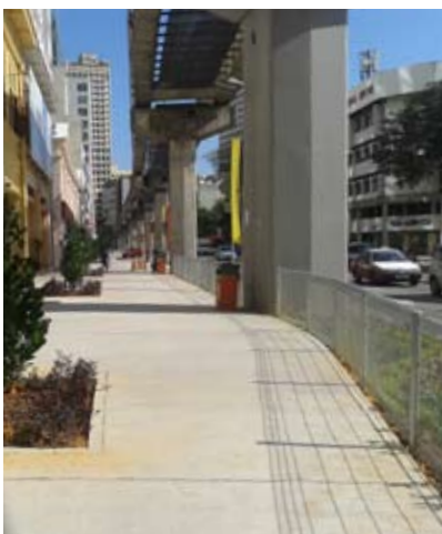
Laluan pejalan kaki sepanjang Jalan Tun Perak
