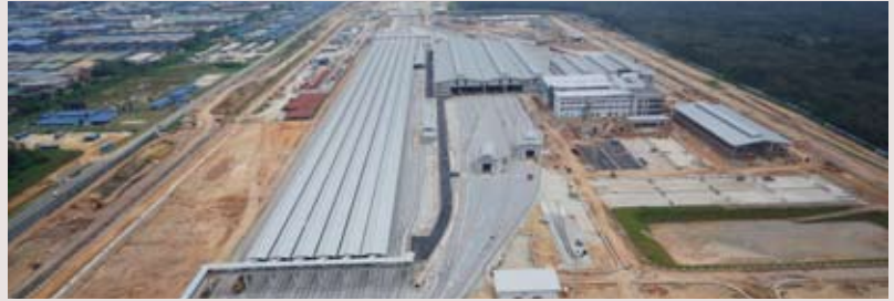
MRT Laluan 1 Sungai Buloh Depot dalam proses pembinaan
